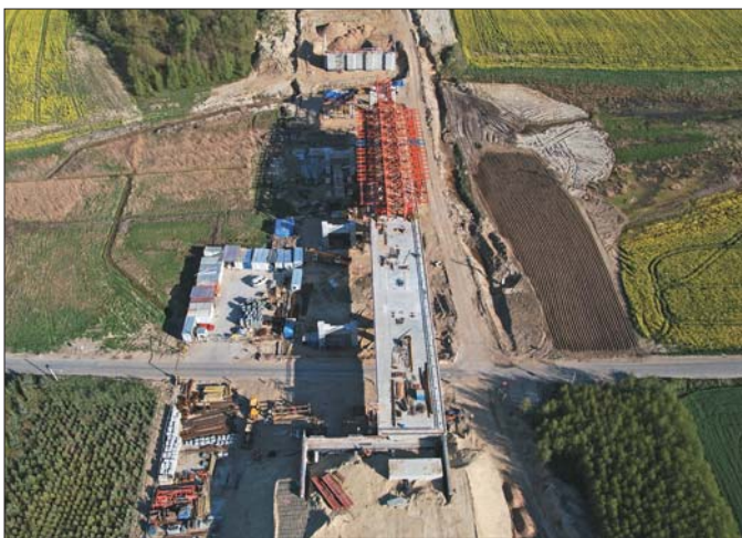
Na budowanym przez GTC odcinku A1 trwają prace na obiektach mostowych
