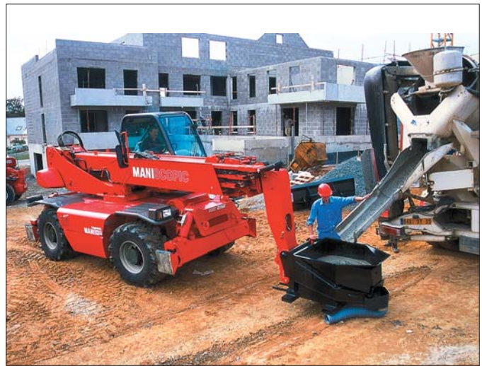
Ładowarka teleskopowa z obrotem MANITOU MRT 2150 M Series wyposażona w kosz do transportu betonu
