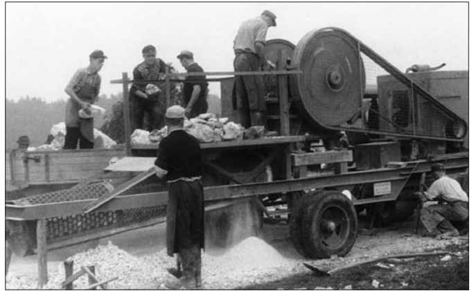
Już w roku 1930 inżynierowie Kleemanna zapoczątkowali erę mobilnych kruszarek posadawiając maszynę na podwoziu kołowym
