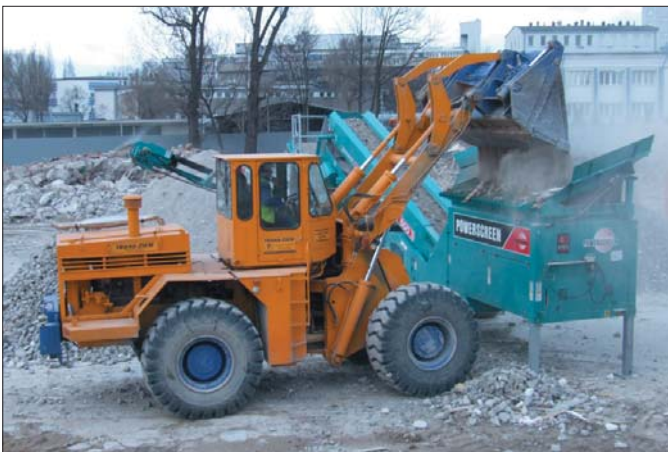
Budowa w warunkach miejskich wiąże się najczęściej z koniecznością wyburzeń prowadzonych przez wyspecjalizowane firmy. Odpady budowlane przetwarzają one na miejscu. Podczas robót na terenie warszawskich obiektów Waryńskiego korzystano z maszyn znajdujących się w ofercie MPS Sp. z o.o.
