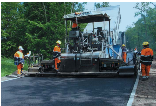
Skanska była wykonawcą przebudowy drogi wojewódzkiej nr 632 Marki-Legionowo. Ostatnie prace polegały na ułożeniu finalnej warstwy nawierzchni bitumicznej na odcinku o długości 3,4 km
