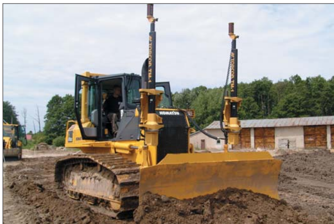
Operator spycharki gąsienicowej Komatsu D61 zaprezentował możliwości automatycznego systemu laserowego 2D
