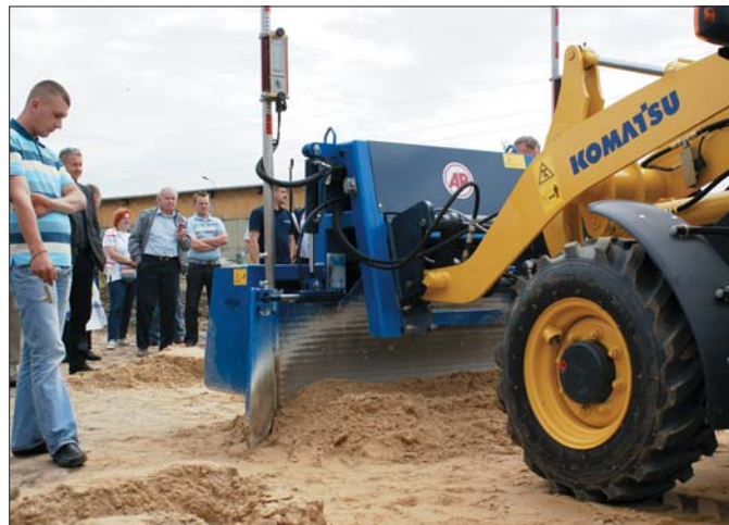
Dużym zainteresowaniem cieszyły się pokazy możliwości niwelacji terenu za pomocą levellera zamontowanego na ładowarce kołowej Komatsu WA65
