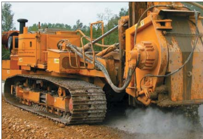
Maszyny Mastenbroek umożliwiają głębokie mieszanie gruntu do 12 m głębokości, wraz z materiałami wiążącymi takimi jak bentonit i cement i tym samym jego utwardzanie
