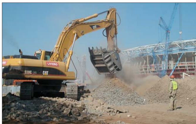
Czerpaki kruszące MB wykorzystywano m.in. na budowie stadionu w Johannesburgu, na którym 11 lipca przyszłego roku rozegrany będzie finałowy mecz Mundialu
