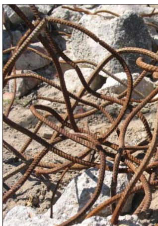
Pozostałości zbrojeń muszą być usunięte zanim materiał porozbiórkowy trafi do kruszarki
