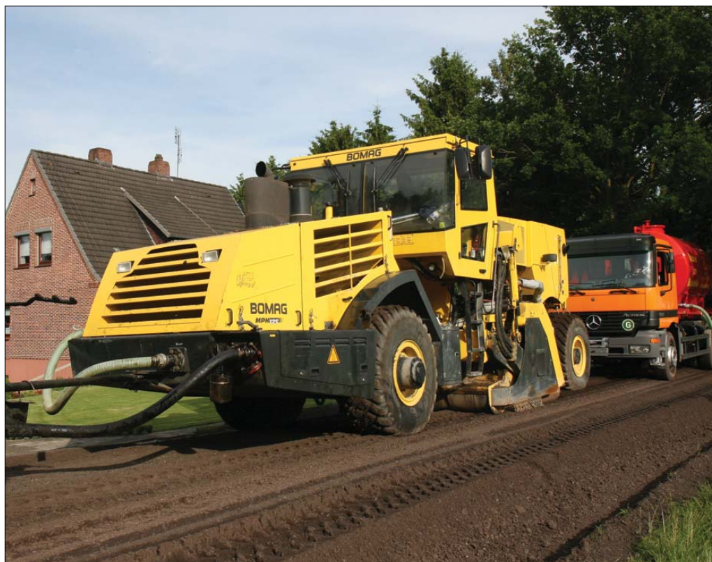
Kluczową maszyną podczas wykonywania robót był recykler BOMAG MPH 125, który wykorzystywano zarówno do usuwania niestabilnej warstwy nawierzchni, jak i rozdrabniania oraz granulowania otrzymanego w ten sposób destruktu
