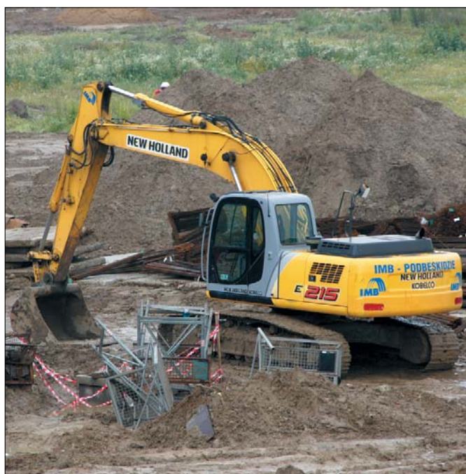
Koparka New Holland E215B wykorzystywana jest przez firmę IMB-Podbeskidzie między innymi na budowie Południowej Obwodnicy Warszawskiej
