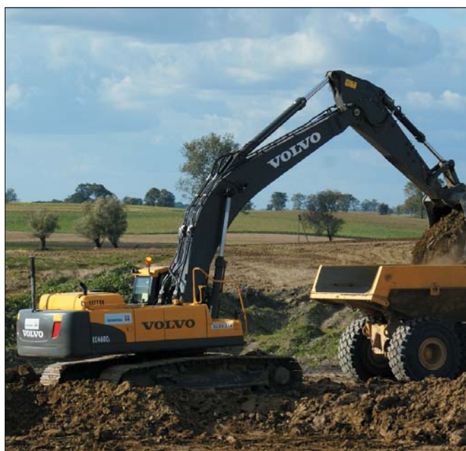
Konsorcjum Skanska-NDI budujące północną część autostrady A1 wykorzystuje wozidła przegubowe Volvo i nowoczesne koparki gąsienicowe tej marki
