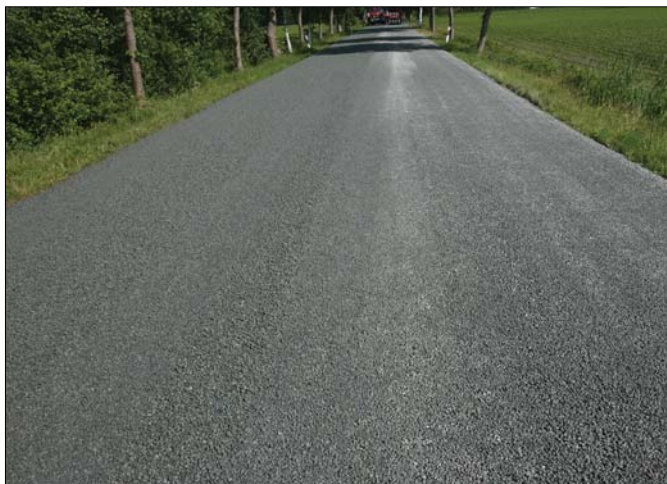
Odnowienie nawierzchni drogi powiatowej K 101 wypadło zadowalająco. Ruch pojazdów mógł zostać w pełni wznowiony już po czterech dniach
