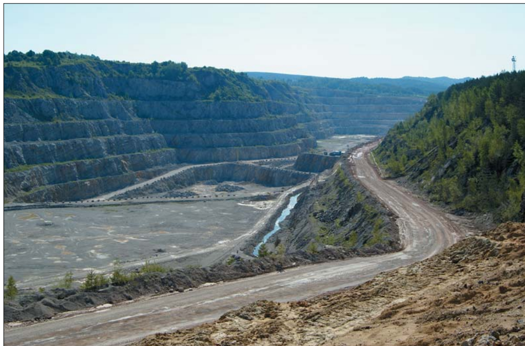
Miedzianka jest obecnie największym zakładem górniczym Nordkalk z wydobyciem około czterech milionów ton rocznie i z najgłębszą kopalnią odkrywkową o głębokości stu metrów
