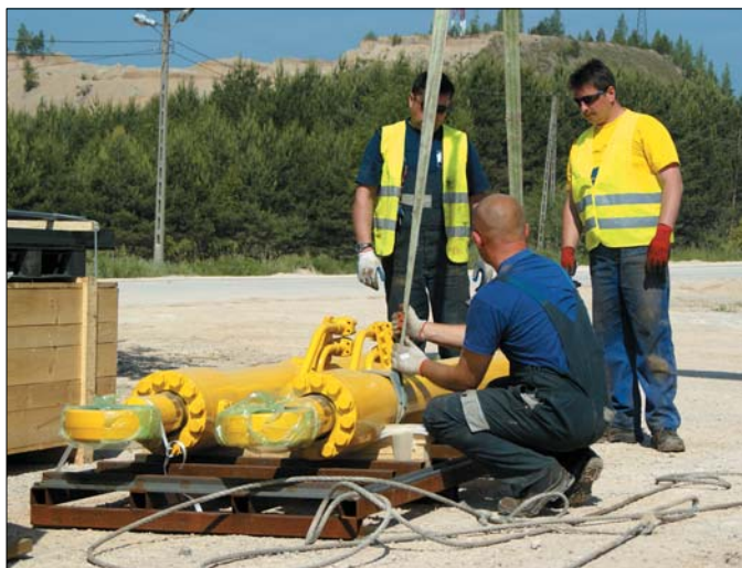
Każdy z siłowników koparki waży 810 kg, co dodatkowo komplikowało montaż
