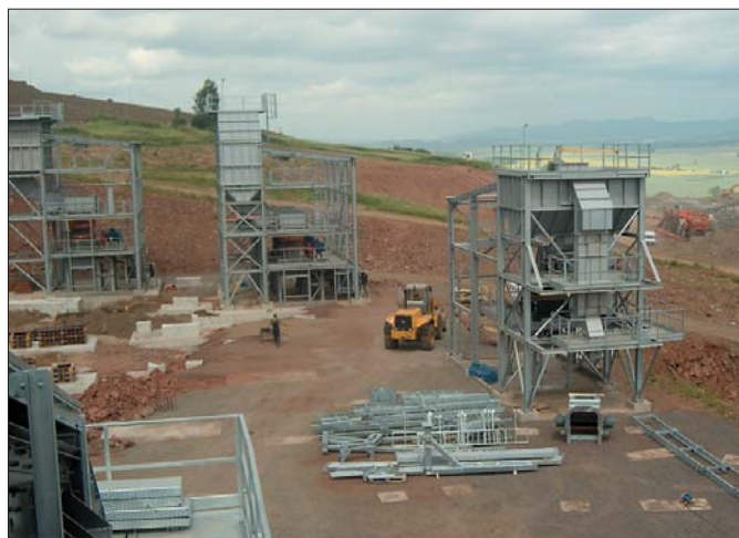
Plany inwestycyjne Strateg Capital od samego początku zakładały powstanie nowoczesnego zakładu stacjonarnego, który pozwoliłby osiągnąć zakładaną wydajność wydobywania na poziomie 2,4 miliona ton przy jednoczesnym zoptymalizowaniu jej kosztów
