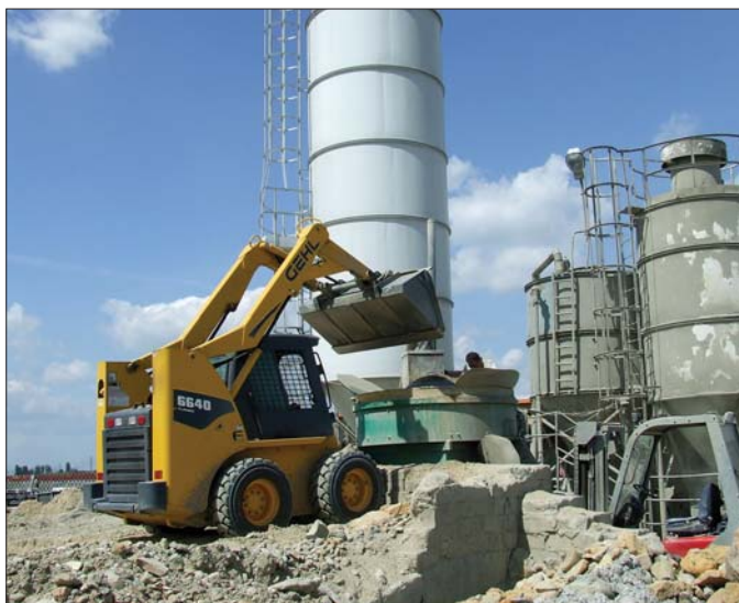
Ładowarka GEHL SL6640 w akcji- przy mieszalniku betonu
