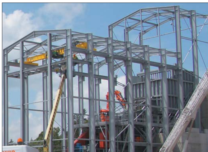
Potężne elementy konstrukcji stalowych trafiły na plac budowy zimą. Choć transportujące je pojazdy pokonać musiały kręte często oblodzone drogi, przewoźnicy podolali zadaniu i montaż rozpoczął się planowo
