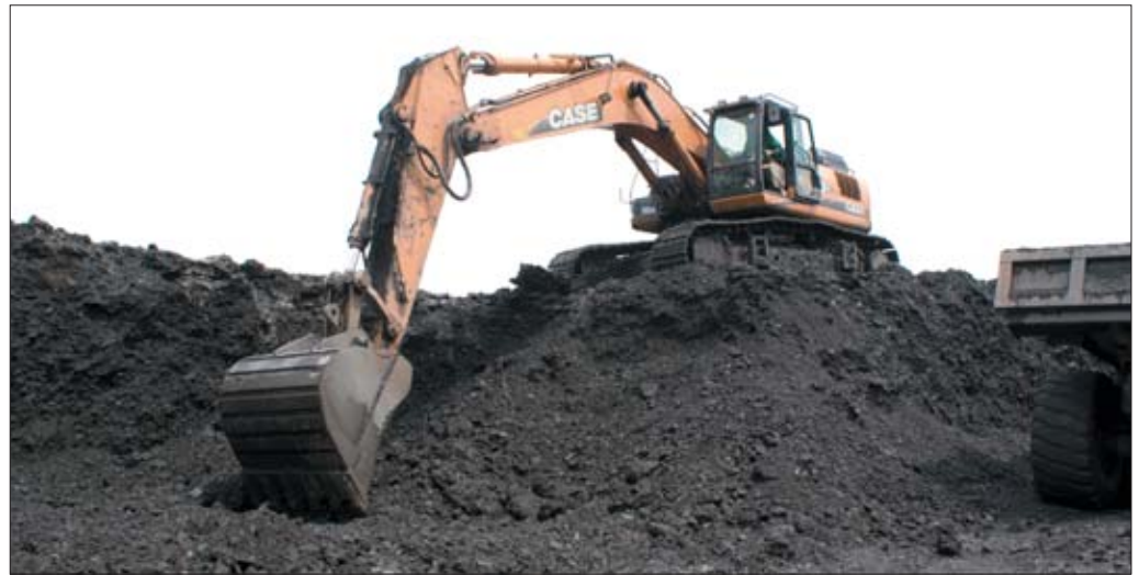
Głównymi zadaniami koparki gąsienicowej Case 470B pracującej bezpośrednio na hałdzie w Zakładzie Panewniki jest urabianie materiału i załadunek wozideł
