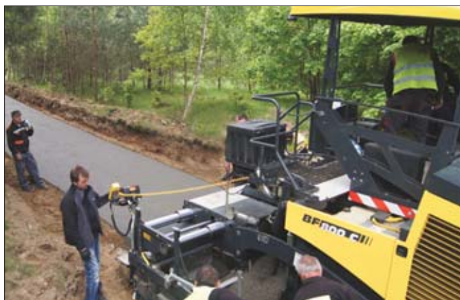
Choć rozkładarka BF 800C zaprojektowana została do rozkładania mas bitumicznych, niezwykle sprawnie radziła sobie z układaniem betonu
