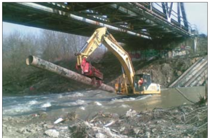
Uchwyt boczny wibromłota Movax ułatwia operatorowi koparki wykonanie prac na skarpace, zboczach, pod wiadukami i mostami
