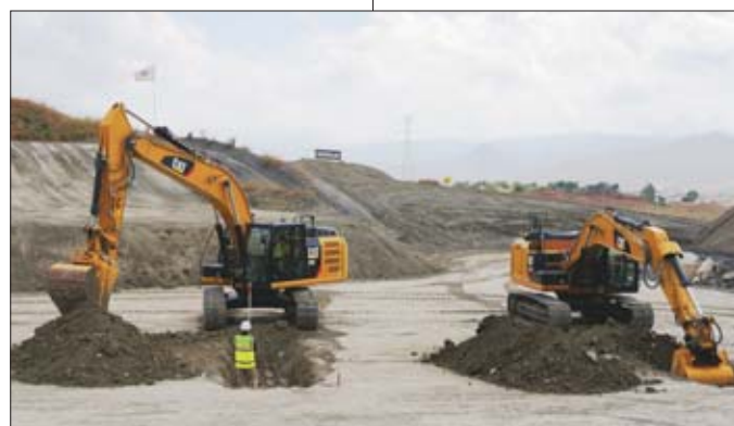
Obserwacja efektów równoległej pracy maszyny kopiącej w sposób tradycyjny i wyposażonej w laserowe mierniki przekonywała o zaletach systemu Cat Grade Control
