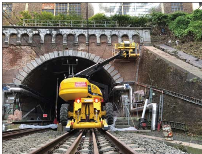
Zwarte gabaryty maszyny spełniają normy umożliwiające wykorzystywanie jej w sąsiedztwie czynnego toru, na którym przez cały czas odbywa się ruch pociągów
