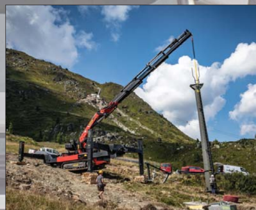
Palfinger PCC 115.002 – udany test na wysokości 50. ▶
