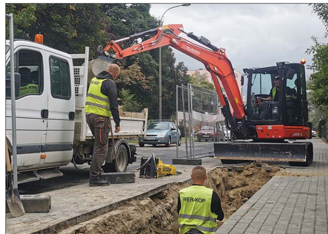
Firma WER-KOP na co dzień realizuje przede wszystkim inwestycje związane z budową i modernizacją sieci ciepłowniczych
