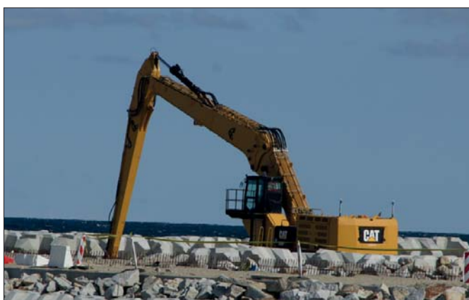
Dzięki zainstalowanemu systemowi operator koparki może precyzyjnie wykonać pracę także sięgając łyżką poniżej lustra wody
