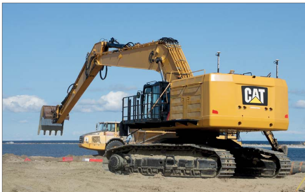
Do robót ziemnych prowadzonych przy przekopie Mierzei Wiślanej z dużym powodzeniem wykorzystywane są duże koparki wyposażone w system sterowania pracą Unicontrol 3D
