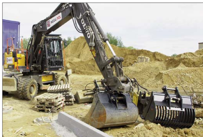
Dzięki zastosowaniu dodatkowego osprzętu ta sama koparka może być stosowana do wykonania wielu całkowicie odrębnych zadań budowlanych
