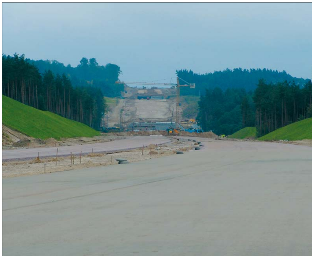
Na budowie autostrady A1 będącej w zamyśle jedną z najważniejszych tras nie tylko Polski, ale całego kontynentu pracuje obecnie ponad osiemdziesiąt maszyn marki Volvo
