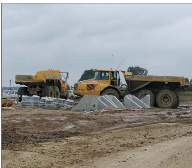
Wozidła Volvo A40 nie były dotychczas stosowane w tak dużej liczbie na żadnym placu budowy w Polsce. Są one stosowane wszędzie tam, gdzie w trudnych warunkach terenowych trzeba przemieszczać szybko niewyobrażalne wprost ilości mas ziemnych
