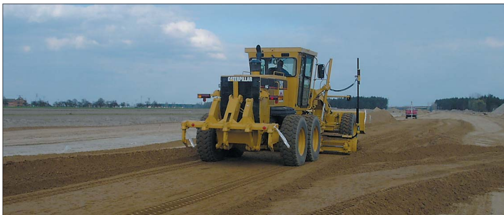
Równiarka firmy Wakoz na budowie autostrady A-2
