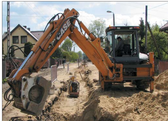
Zagęszczarką STANLEY serii HS, przy optymalnej wilgotności i ziarnistości zagęszczanego materiału można uzyskać stopień zagęszczenia gruntu powyżej 95 procent
