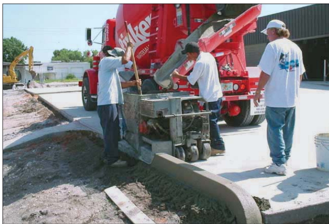
CT-3000 tworzy krawężnik o dowolnym profilu i kształcie z prędkością do 40 metrów na minutę
