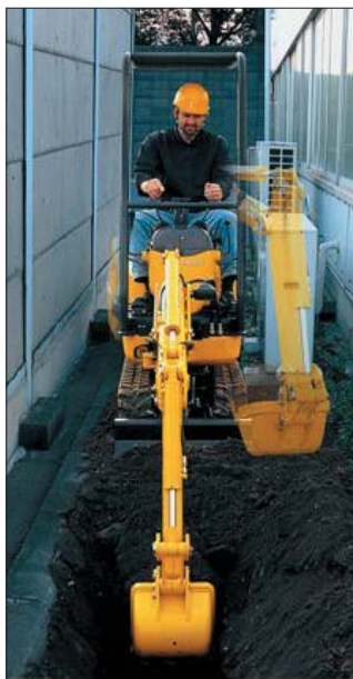
Najmniejsza z minikoparek Komatsu – model doskonale nadaje się do prac na ograniczonej przestrzeni, na przykład pomiędzy blisko ustawionymi ścianami
