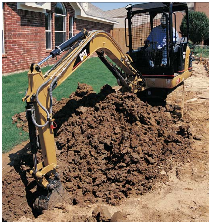
Maszyny są z powodzeniem wykorzystywane przez małe i średniej wielkości firmy budowlane oraz wszędzie tam, gdzie duża maszyna nie byłaby w stanie nawet wjechać
