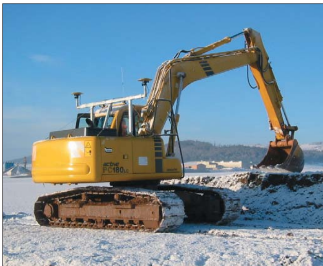
Anteny zainstalowane na koparce odbierają sygnały z satelitów GPS i GLONASS
