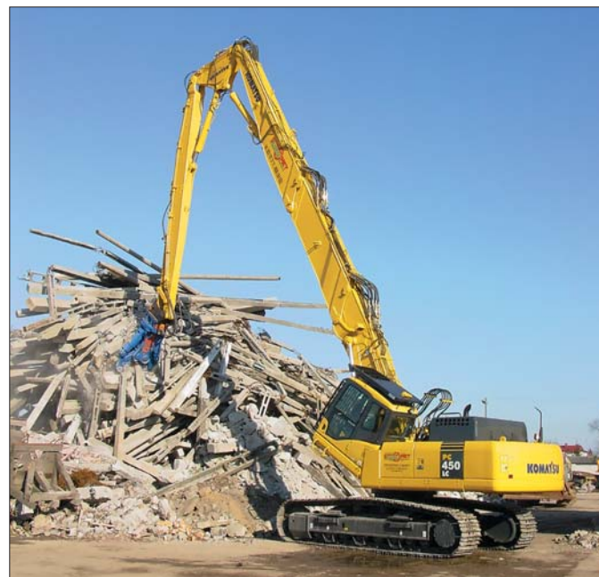
Komatsu oferuje maszyny specjalnego przeznaczenia. Jedną z nich jest przeznaczona głównie do robót wyburzeniowych koparka PC450LC
