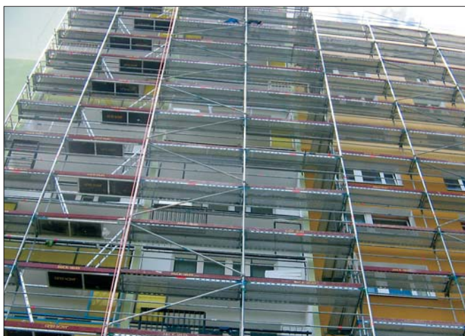
Pomosty stanowią też podłużne usztywnienie konstrukcji
