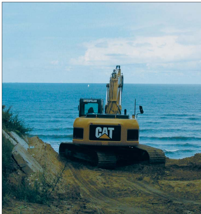
Praca przy upalnej pogodzie nie należy do najprzyjemniejszych. No, chyba, że ma się klimatyzację i tak wspaniały widok z maszyny...
