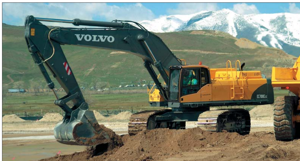
Jednym z typowych zastosowań koparki Volvo EC700CL jest przemieszczanie dużych mas ziemnych
