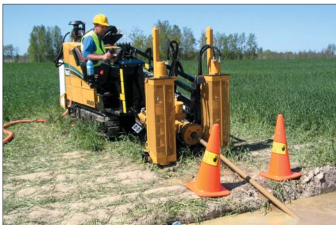
Sterowane wiercenia horyzontalne wydłużają czas wykonania nowych instalacji, zwiększają bezpieczeństwo pracy oraz nie naruszają istniejącej infrastruktury
