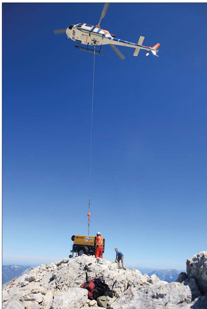
Sprężarkę CompAir C50 przetransportowano na szczyt za pomocą śmigłowca
