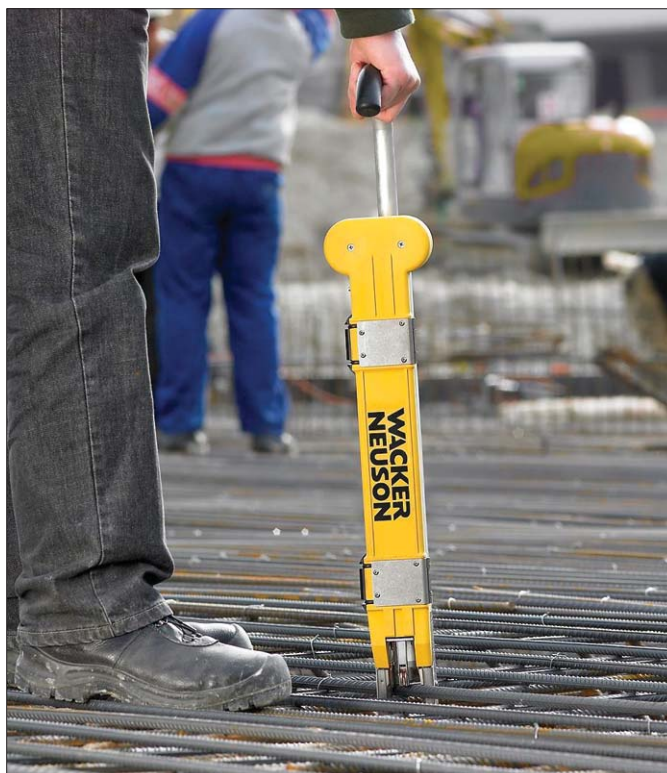
Dzięki zastosowaniu DF 16 można w dużym stopniu uniknąć w szczególności uciążliwego, głębokiego pochylania się. Za sprawą jednoręcznej obsługi narzędzia wiązanie prętów zbrojeniowych stało się zdecydowanie prostsze i mniej męczące
