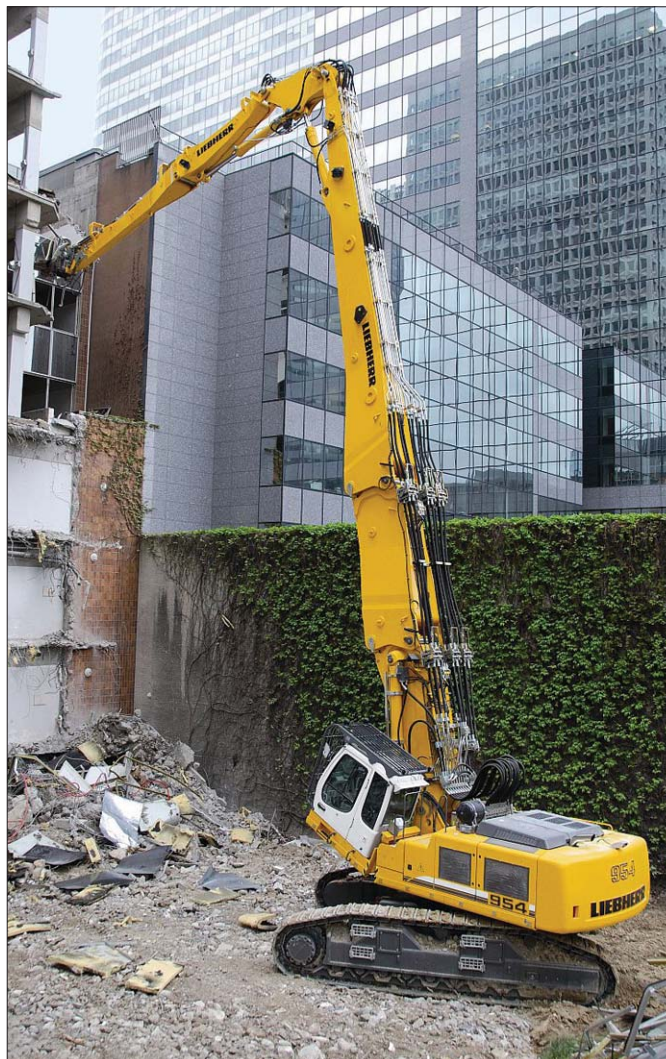
Koparka do wyburzeń Liebherr R 954 C VH-HD wyposażona w szybkozłącze typu Likufix może wykonywać prace na wysokości do 34 metrów
