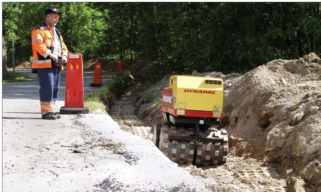
Walec Dynapac LP8500 o masie operacyjnej 1.675 kg wyposażony jest w zdalne sterowanie za pomocą fal radiowych. Maszyna przeznaczona jest przede wszystkim do zagęszczania gruntu w rowach i wykopach
