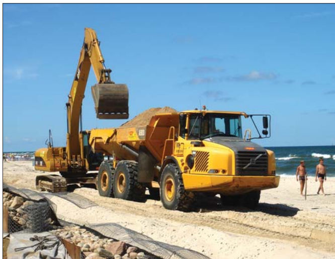
W sezonie teren budowy nie sięgał też do samej wody. Prace prowadzone były na połowie szerokości plaży, reszta była dostępna dla spragnionych słońca urlopowiczów
