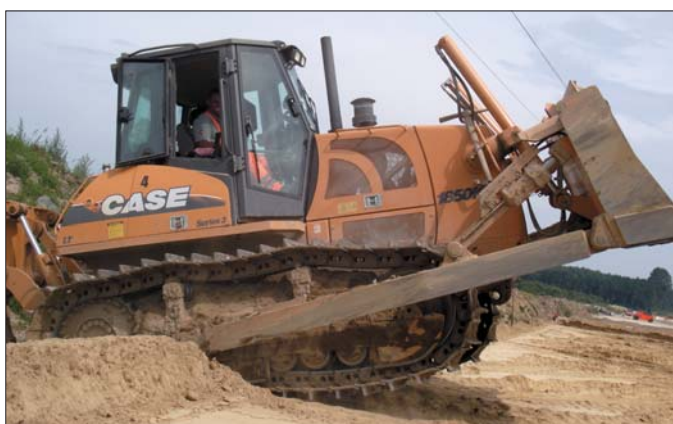
Na budowie odcinka autostrady A4 pomiędzy węzłami Brzesko i Wierchosławice pracuje dziesięć spycharek Case 1850K klasy 20 ton
