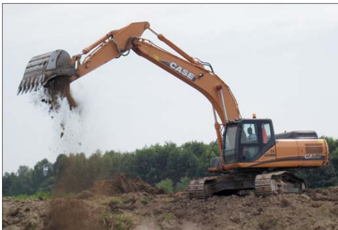
Realizujący prace pomiędzy węzłami Brzesko i Wierchosławice są bardzo zadowoleni z wydajności i niezawodności koparek Case
