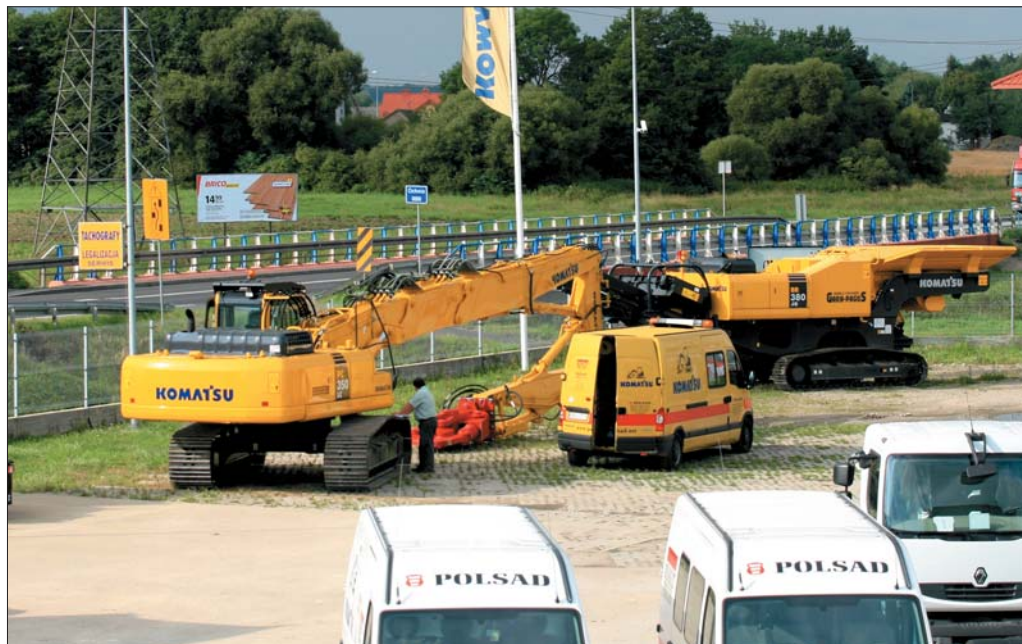
Inspekcja serwisowa przeprowadzana przed wydaniem klientowi koparki wyburzeniowej Komatsu PC350HRD-8 oraz kruszarki Komatsu BR380JG
