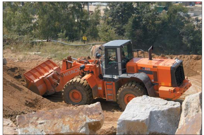
Osprzęt jest często zmieniany. W zależności od potrzeb maszyna pracuje z użyciem łyżki wykonując typowe prace ziemne i przeladunkowe
