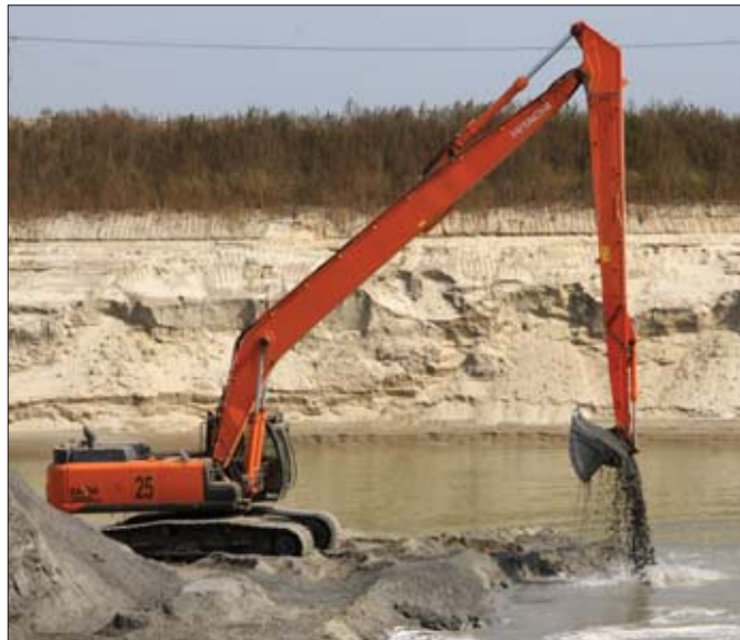
Eksploatacja pokładów piasku w Gniewczynie jest niezwykle intensywna i skomplikowana pod względem technicznym. Maszyny pracują w trudnych warunkach terenowych, a większość wydobycia prowadzona jest spod powierzchni wody
