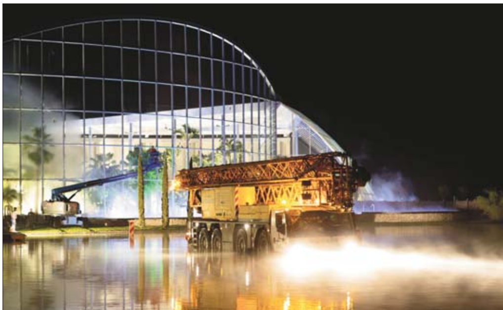
Wymiana szklanych płyt elewacyjnych na fasadzie krytej pływalni musiała być przeprowadzona błyskawicznie poza godzinami otwarcia basenu, aby nie zakłócało to normalnego funkcjonowania kąpieliska
