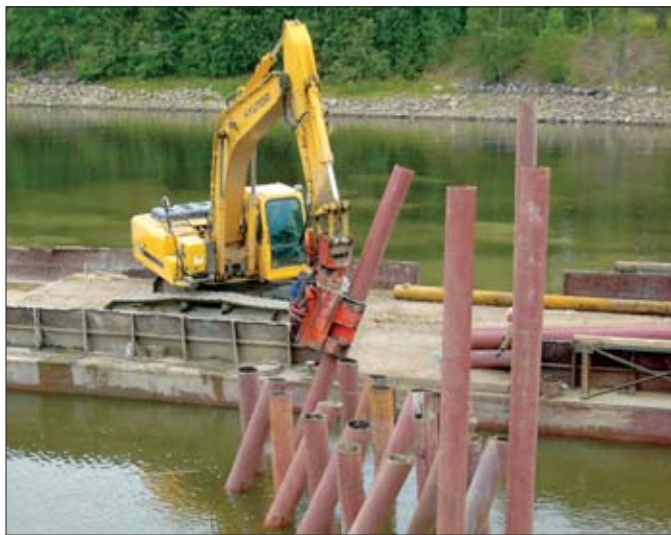
Typowy dla wibromłotów MOVAX uchwyt boczny pozwala trzymać wbijany element w odpowiedniej pozycji, dzięki czemu znika ograniczenie maksymalnej długości wbijanej grodzicy, profilu lub rury
