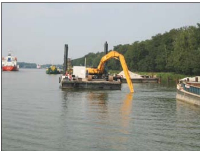
Dwie sześćdziesięcotonowe koparki gąsienicowe Hyundai posadowiono na pontonach. Ich zadaniem jest rozładunek granitowego kruszywa z barek i przemieszczenie go na dno zbiornika wodnego celem jego umocnienia
