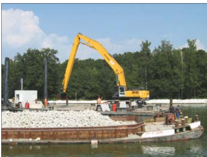
Realizacja tak skomplikowanych inwestycji wymaga stosowania specjalistycznego niezawodnego sprzętu. Dlatego też Energopol SA zdecydował się na zakup dwóch sześćdziesięcotonowych koparek Hyundai R500LC-7A SLR (Super Long Reach)
