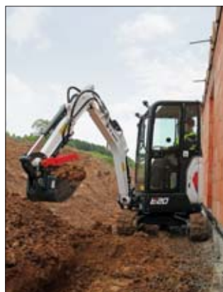
Koparka Bobcat E20 sprawdza się podczas pracy w pobliżu ścian budynków
