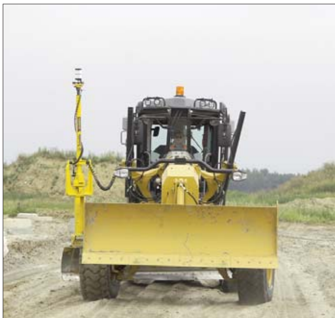
Zainstalowany na równiarce system Trimble GCS900 3D składa się z połączonego z lemiemmasz masztu elektrycznego, lustra 360° i czujników pochylenia
