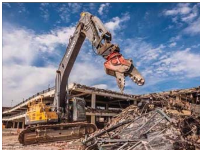
Hydrauliczna głowica umożliwiającą dokonywanie obrotu w zakresie 360° pozwala wykonywać prace rozbiórkowe z maksymalną precyzją
