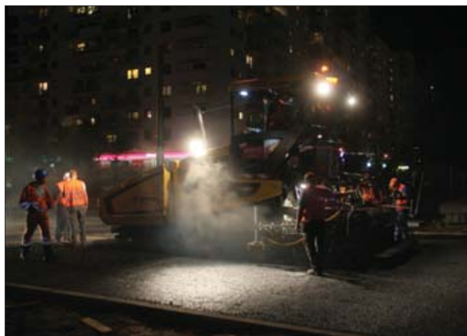
Rozściełacz BF 600 C-2 ma rozbudowany zestaw reflektorów roboczych umożliwiających wydajną i bezpieczną pracę nawet po zapadnięciu ciemności
