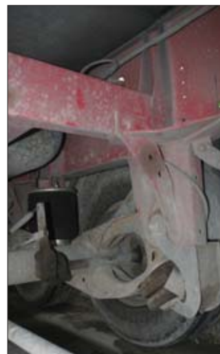
Mimo całego szeregu lat pracy w bardzo trudnych warunkach w żadnym podwoziu nie pojawiły się jakiegokolwiek pęknięcia
