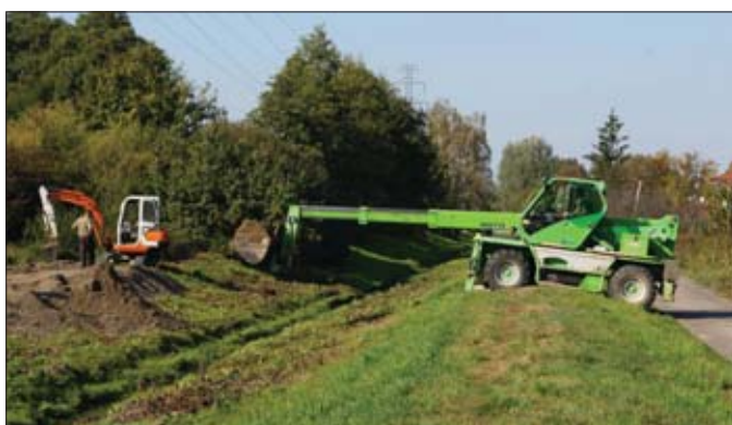
Na kłopoty Merlo! Ładowarka teleskopowa Merlo Roto doskonale spisywała się przy budowie wału przy kanale na warszawskim Wilanowie
