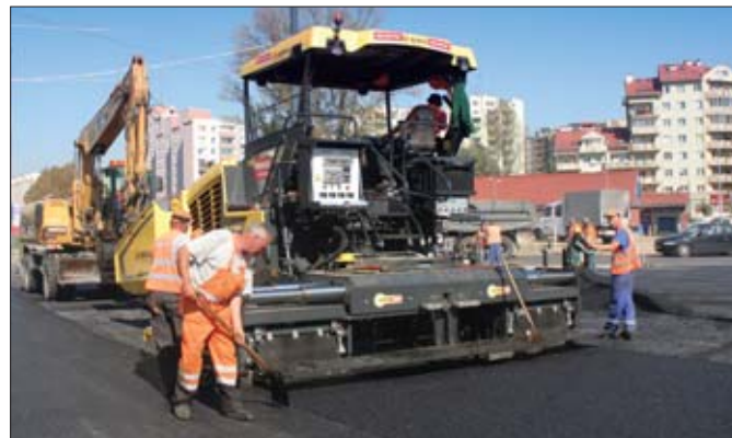
W nowych rozścielaczach BOMAG jest stosowany system MAGMALIFE, który gwarantuje krótki czas nagrzewania stołu układającego do temperatury roboczej
