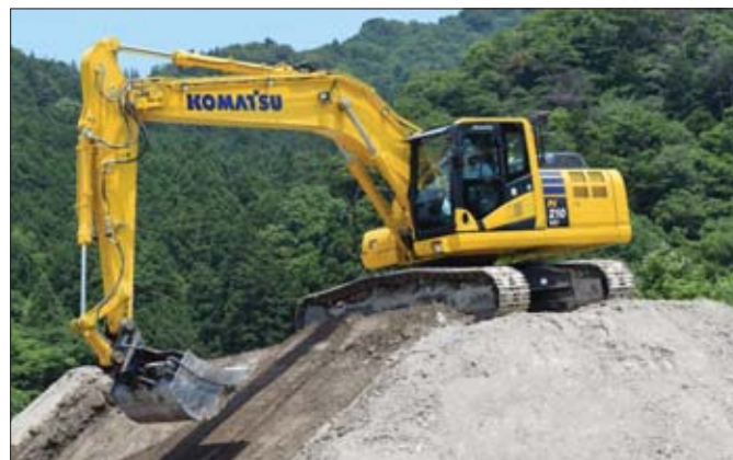
Operator koparki PC210LCi-10 przy zaskakująco niskim wysiłku osiąga doskonałe rezultaty w zakresie tempa i precyzji pracy
