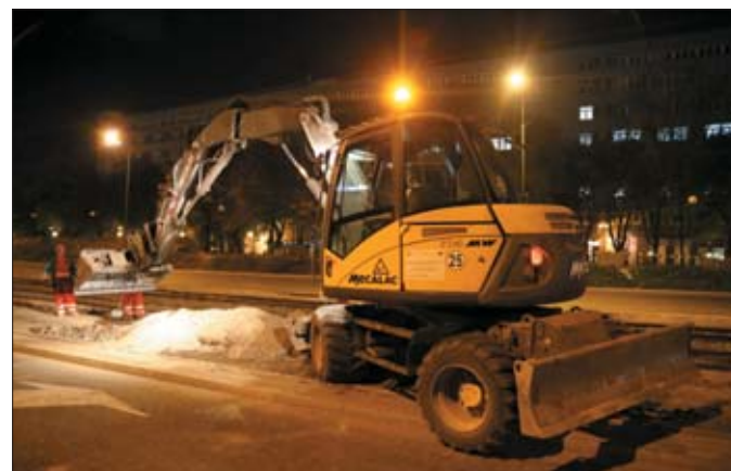
Prace na przejazdach, torowiskach, przejściach dla pieszych i przy peronach przystankowych skutecznie wspomagały koparki Mecalac 714 MWe
