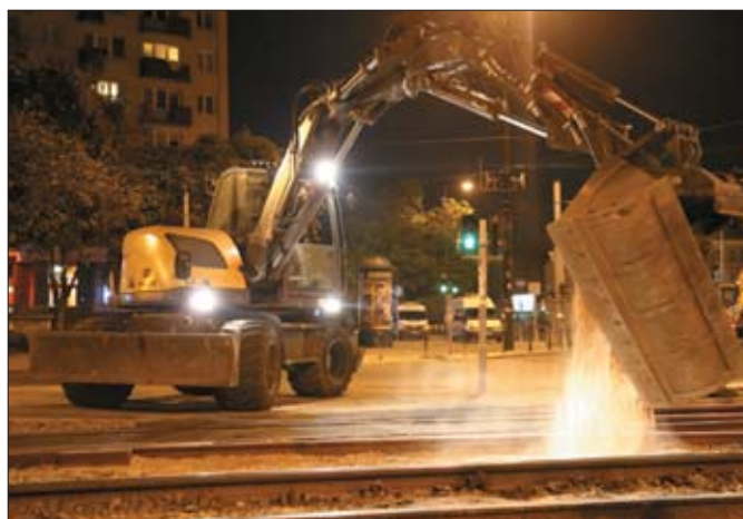
Jak widać Mecalac 714 MWe nie służy wyłącznie do kopania. Podczas prac na torowisku doskonale spisuje się także w innych zastosowaniach
