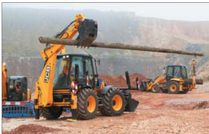
Koparko-ładowarka JCB 4CX Polemaster+ to znakomite rozwiązanie dla firm energetycznych, bo pozwala na wykonanie wielu niezbędnych prac związanych z montażem słupa bez angażowania innych maszyn
