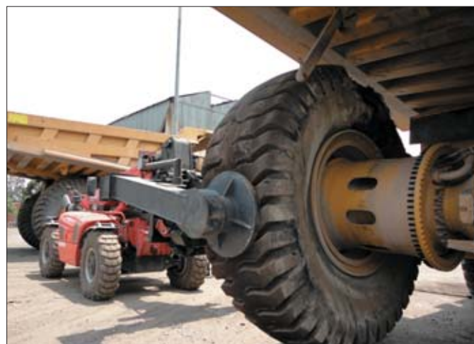
Wszechstronność maszyn Manitou potrafią docenić także górnicy powierzchniowi wykorzystujący je do bardzo skomplikowanych prac remontowych
