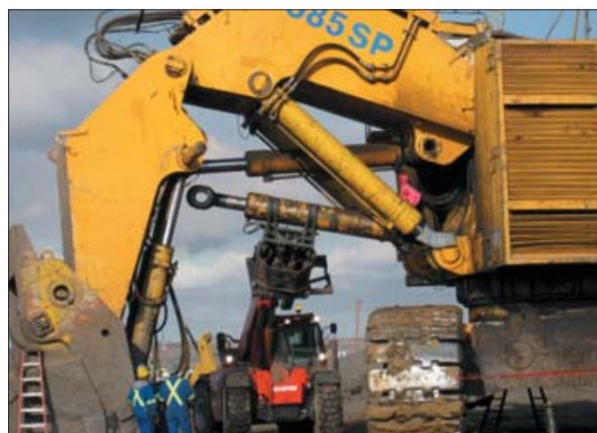
Jak sprawnie dokonać zabiegu polegającego na demontażu tak ogromnego siłownika? Wystarczy posłużyć się górniczym Manitou
