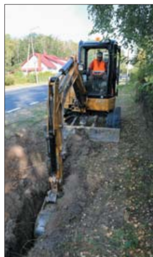
Główną rolę minikoparek Cat stosowanych przy układaniu światłowodu jest realizacja podłużnych wykopów o głębokości minimum 1.000 mm i szerokości 300 mm, a następnie zasypywanie ich za pomocą łyżki skarpowej o szerokości 1.200 lub 1.500 mm
