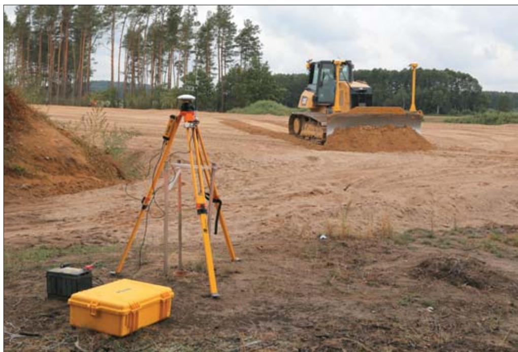
Spycharka Cat D6K wyposażona w system Trimble zwykle pracuje w odległości do 200-300 metrów od stacji bazowej. Zdarzyła się już jednak sytuacja, gdy maszyna musiała odjechać na 1,5 kilometra, ale system nadal działał prawidłowo
