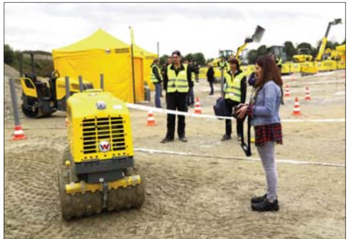
Nowe walce Wacker Neuson do robót ziemnych wyróżniają się dużą wydajnością zagęszczania, ekonomiczną eksploatacją i znakomitą zwrotnością
