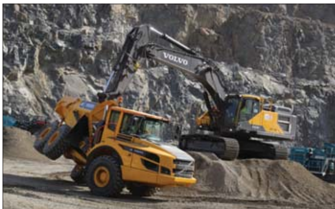
„Na poziomie 308” obserwowaliśmy balet maszyn budowlanych sterowanych przez mistrzów w swym fachu z Polski, Szwecji i Niemiec
