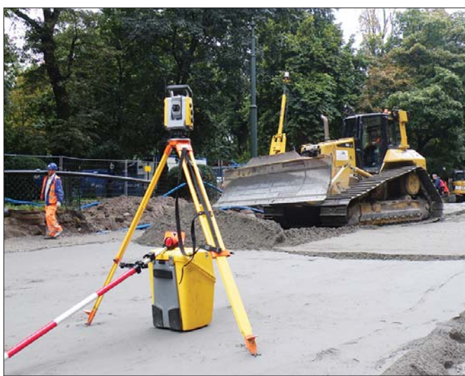
Dzięki zastosowaniu zrobotyzowanego tachimetru system sterowania spycharką Trimble UTS doskonale sprawdza się w gęsto zabudowanych terenach miejskich
