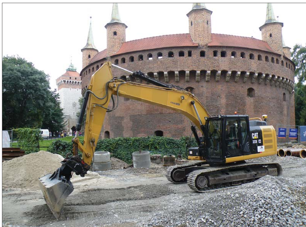
System automatycznego sterowania koparką Trimble Earthworks swój „chrzest bojowy” przechodzi podczas prac modernizacyjnych związanych z budową nawierzchni ulicy Basztowej przy krakowskim Barbakanie
