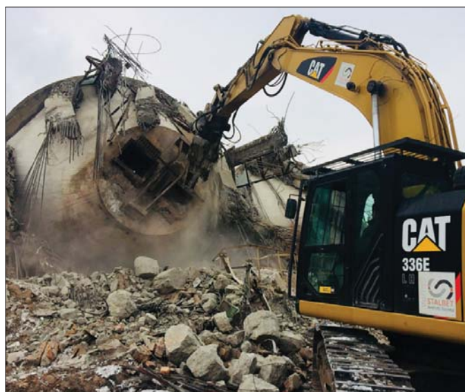
Maszyny, narzędzia i fachowość operatorów stanowią gwarancję sprawnego przeprowadzenia nawet najbardziej skomplikowanych wyburzeń i rozbiórek
