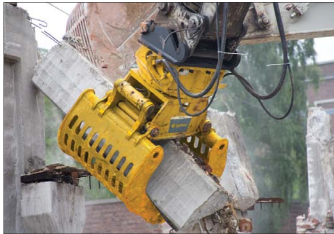
Solidna konstrukcja chwytaków do gruzu Epiroc sprawia, że nadają się one zarówno do sortowania i załadunku materiałów, jak i lekkich prac wyburzeniowych
