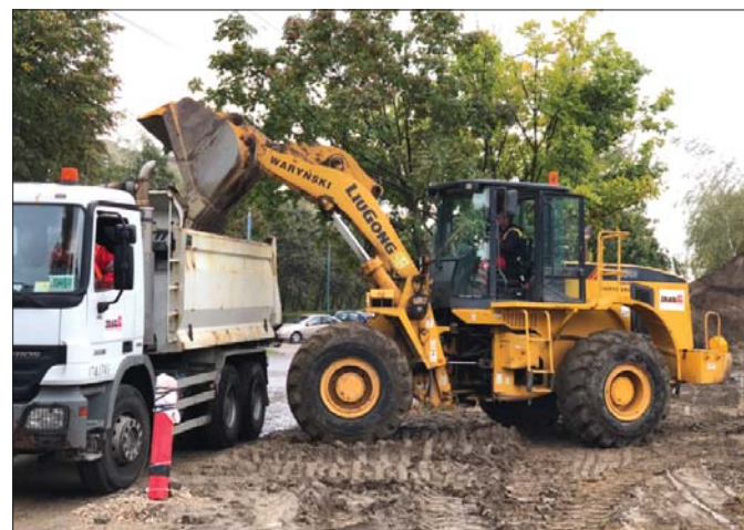
Eksploatowana intensywnie maszyna załaduje pojazdy ciężarowe, których zadaniem jest przewóz mas ziemnych i odpadów budowlanych w inne miejsce
