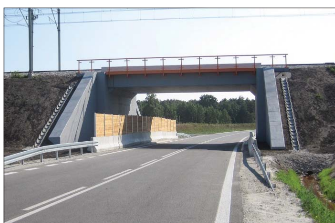
Pierwotny plan zakładał wybudowanie wiaduktu nad torowiskiem, jednak ze względów finansowych inwestor zdecydował się na przebiecie się przez nasyp toru kolejowego
