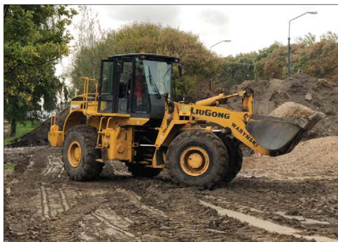
Na Puławskiej trwa budowa ścieżek rowerowych i nowych chodników. Wykonawcy narzucili sobie ekspresowe tempo, co wymaga intensyfikacji robót
