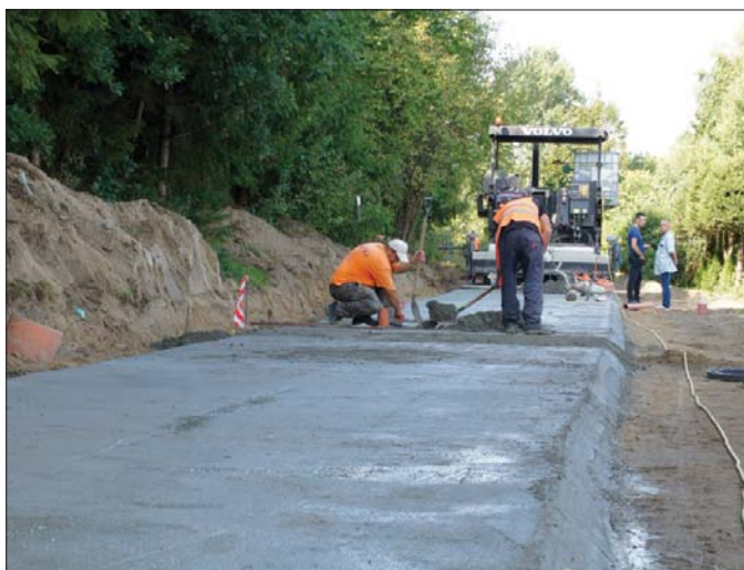
Budownictwem drogowym firma Harat para się już od ponad dwudziestu lat. Prawdziwym „oczkiem w głowie” są dla niej nawierzchnie betonowe
