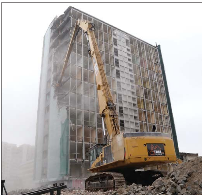
Operowanie osprzętem na wysokości dwudziestu metrów stało się normą umożliwiającą zachowanie dystansu od wyburzanego obiektu
