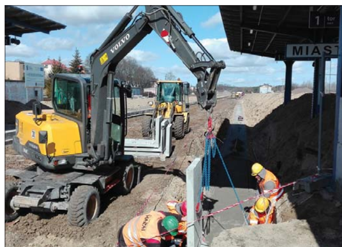
Koparka pracowała w niezwykle ciasnej przestrzeni jako dźwig przenoszący prefabrykowane elementy o wadze siedemset kilogramów każdy
