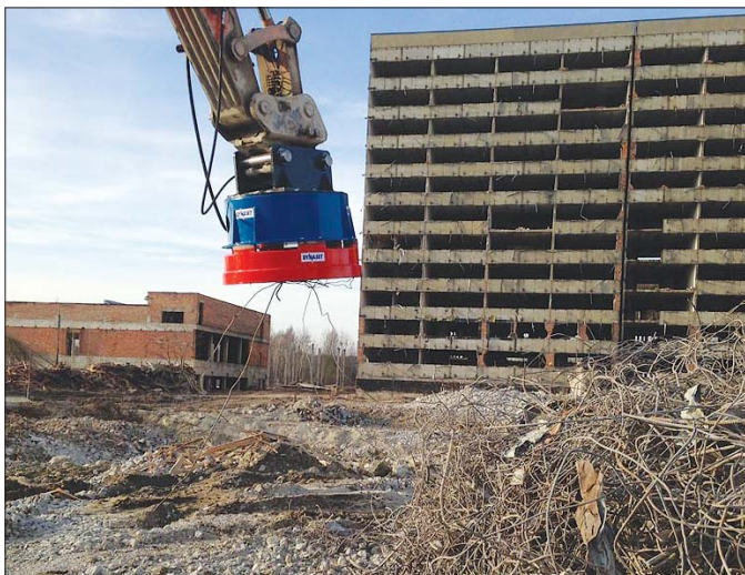
Chwytyki magnetyczne znajdują zastosowanie przy porządkowaniu terenu wyburzeń. Za ich pomocą z gruzu wyciąga się elementy zbrojeń i przenosi ciężkie profile stalowe
