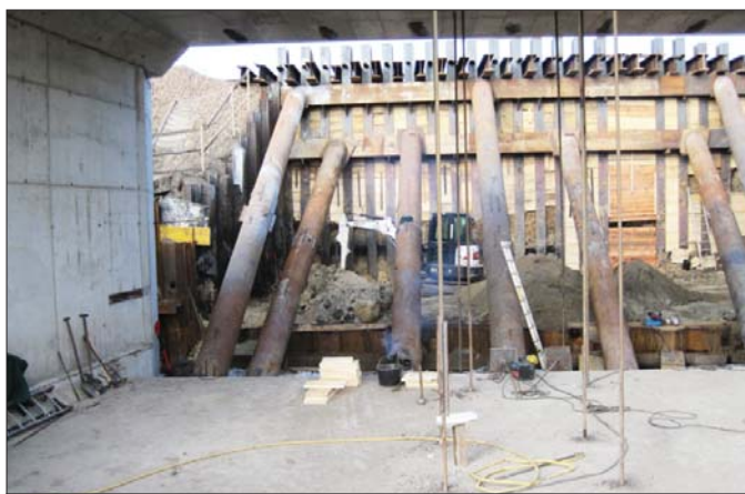
Operacja wykonania przejścia pod torami kolejowymi polegała na „wciśnięciu” pod wiadukt prefabrykowanej, żelbetowej konstrukcji
