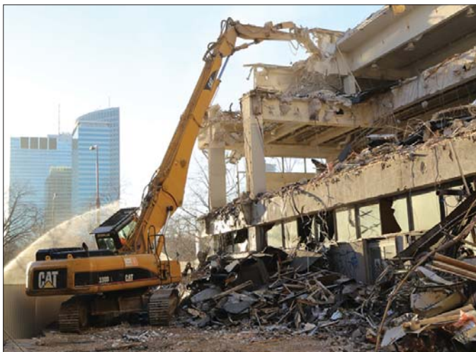
Rozwój konstrukcji maszyn wyburzeniowych wynika ze zmieniających się metod prowadzenia prac. Profesjonalnych wyburzeń dokonuje się metodycznie
