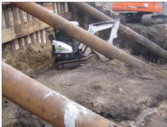
W tak trudnych warunkach na budowie obwodnicy sprawdzić się mogła jedynie koparka, która zmieściłaby się w ciasnej przestrzeni nietypowego placu budowy
