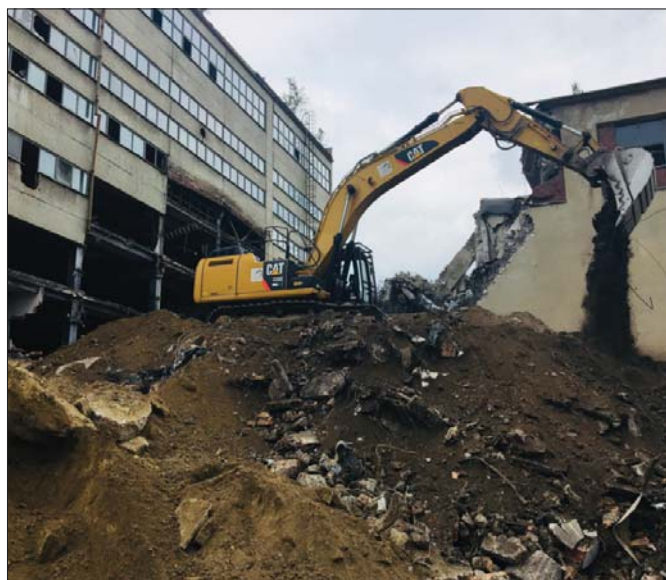
Szybka zmiana konfiguracji wysięgnika pozwala na efektywniejsze wykorzystanie maszyn, na przykład do prac porządkowych na terenie wyburzeń
