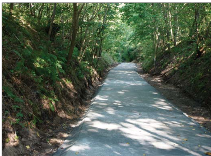
Znaczna część budowanej drogi biegła wąskim wąwozem. Główną trudnością dla pracujących tu maszyn było duże nachylenie terenu
