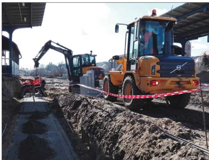
Koparka EW 60E ze względu na swą zwrotność i zwartą budowę doskonale sprawdziła się podczas prac związanych z przebudową peronów dworca w Miastku
