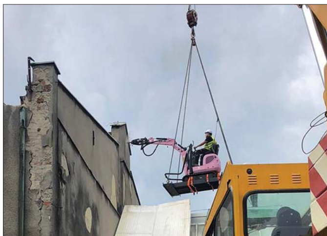
Do rozbiórek używane są koparki różnej klasy, nie tylko gigantyczne maszyny skonstruowane z myślą o wykorzystaniu w przemyśle wydobywczym
