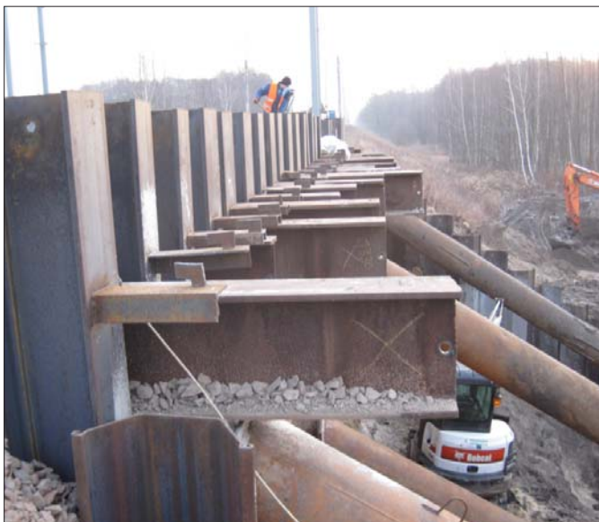
Budowa obwodnicy Miękini stanowiła niezwykle poważne przedsięwzięcie logistyczne i olbrzymie wyzwanie dla firm wykonawczych
