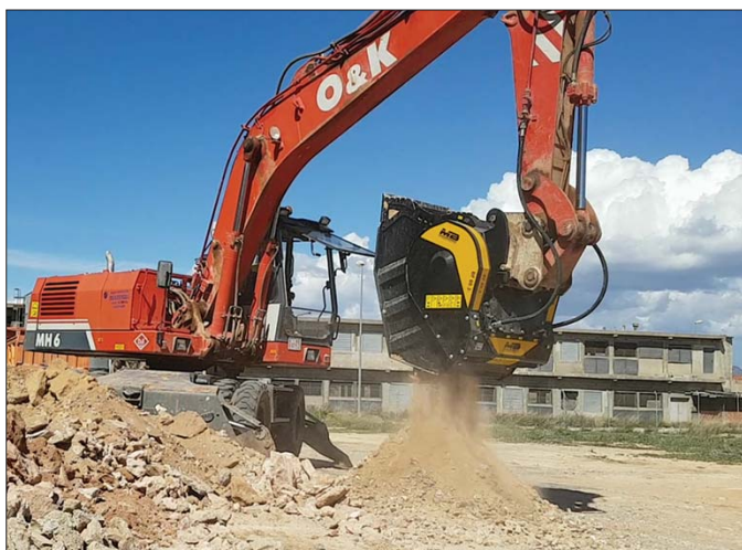
We Francji pewnej firmie udało się przetworzyć prawie cały gruz z rozbiórki starego budynku i ponownie go wykorzystać bezpośrednio na miejscu
