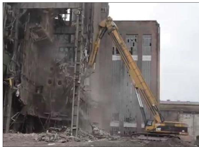
Coraz częściej bardziej zasadne jest wyburzenie i wybudowanie obiektu od nowa niż przebudowa czy skomplikowany logistycznie remont kapitalny
