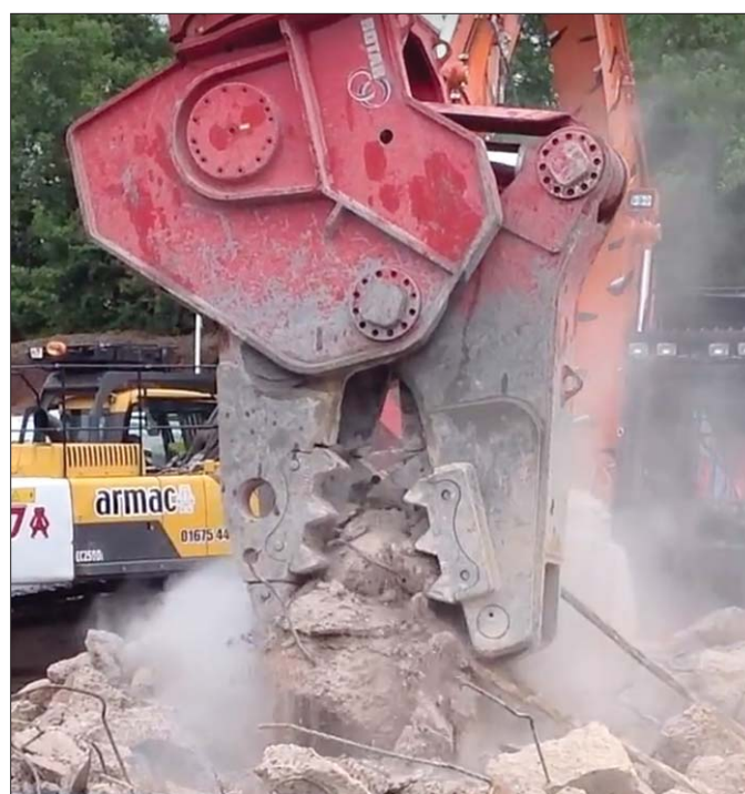
Największe nożyce Rotar RDP 42 S z łatwością dają sobie radę ze zbrojonymi elementami betonowymi o grubości nawet sześćdziesięciu centymetrów
