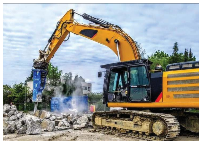
Firma oferuje trzy serie młotów hydraulicznych o masie od 70 do 14.500 kilogramów, które instalować można na koparkach ważących od 1 do 200 ton
