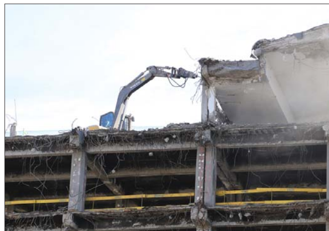
Do prac w mieście wykorzystywane są mniejsze koparki, które za pomocą dźwigu transportowane są na wyższe kondygnacje wyburzanego budynku
