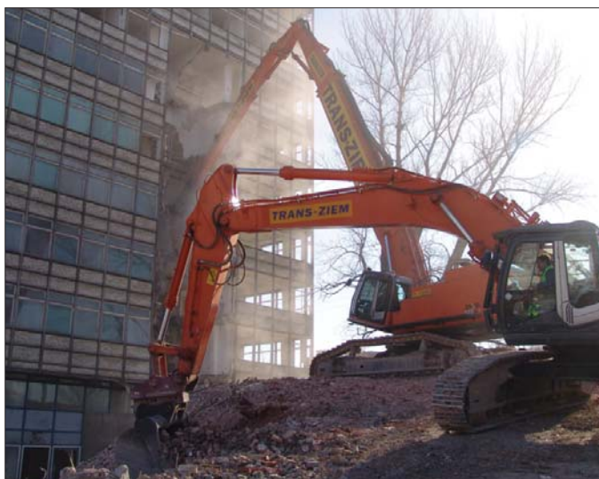
Wielu producentów koparek modyfikuje maszyny przystosowując je do prowadzenia wyburzeń. Przede wszystkim wyposaża je w wysięgniki o zmienionej konstrukcji
