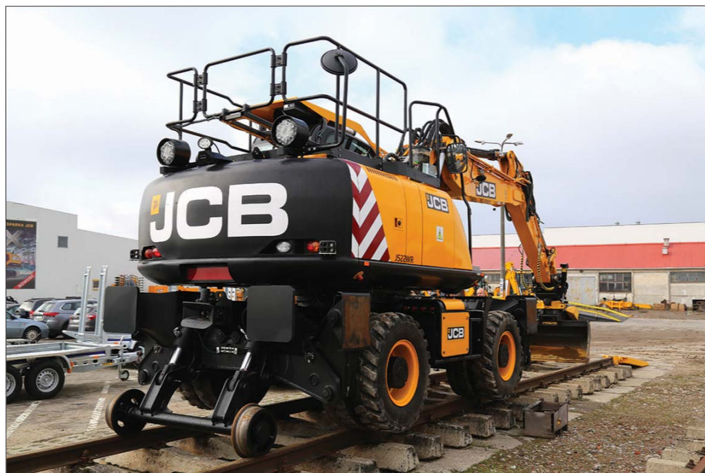
W maszynie bazowej wprowadzono cały szereg zmian konstrukcyjnych i wyposażono ją w systemy elektroniczne umożliwiające bezpieczną i efektywną pracę na torach nawet podczas normalnego ruchu pociągów
