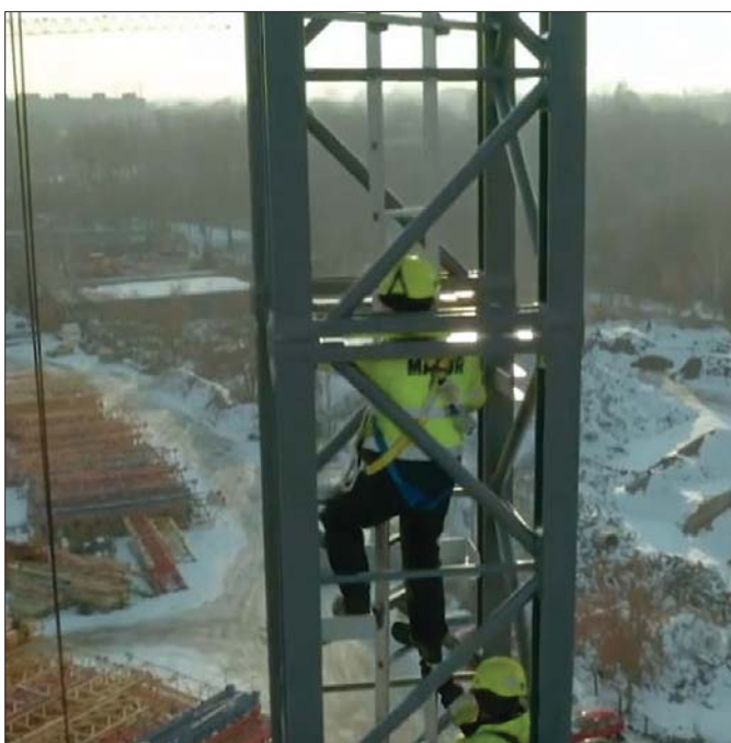
W drodze do kabiny operator żurawia korzysta z systemu drabinek i poręczy. Co sześć metrów rozmieszczone są podesty, na których operator może odpoczywać
