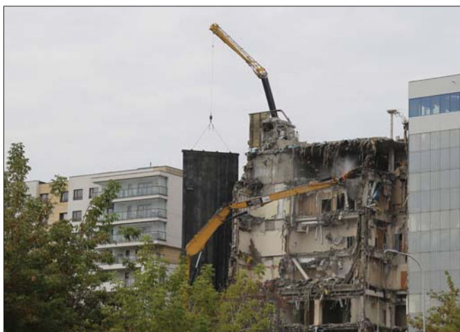
Aby zneutralizować zagrożenie spadającymi odłamkami burzonej konstrukcji, firma Tree stosuje zabezpieczenie w postaci wykonanej z pasów gumowych kurtyny
