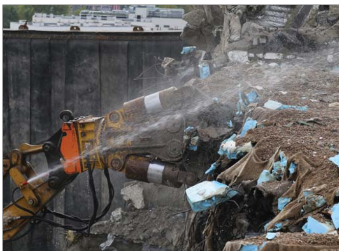
Zraszacze zamontowane na ramieniu wysięgnika koparki ograniczają zapylenie, co poprawia widoczność z kabiny i ułatwia manipulowanie osprzętem
