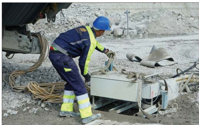
Skrzynka zaciskowa stanowiąca integralny element składowy silnika elektrycznego umieszczona została w pobliżu kruszarki R6e
