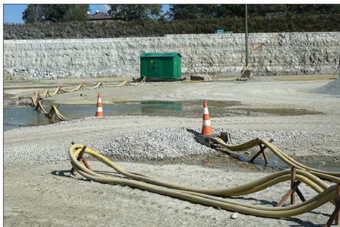
Dzięki dwóm dwustumetrowym ciągom kablowym biegnącym od stacji transformatorowej maszyny mogą być zasilane prądem na obszarze całego wyrobiska
