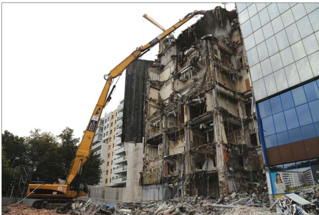
Odpowiedni zasięg roboczy koparki wyburzeniowej poprawia bezpieczeństwo pracy. Dodatkowo maszyna wyposażona jest także w wytrzymałą ramę, większe silowniki wysięgnika czy też dodatkową przeciwwagę pozwalającą zachować pełną stabilność
