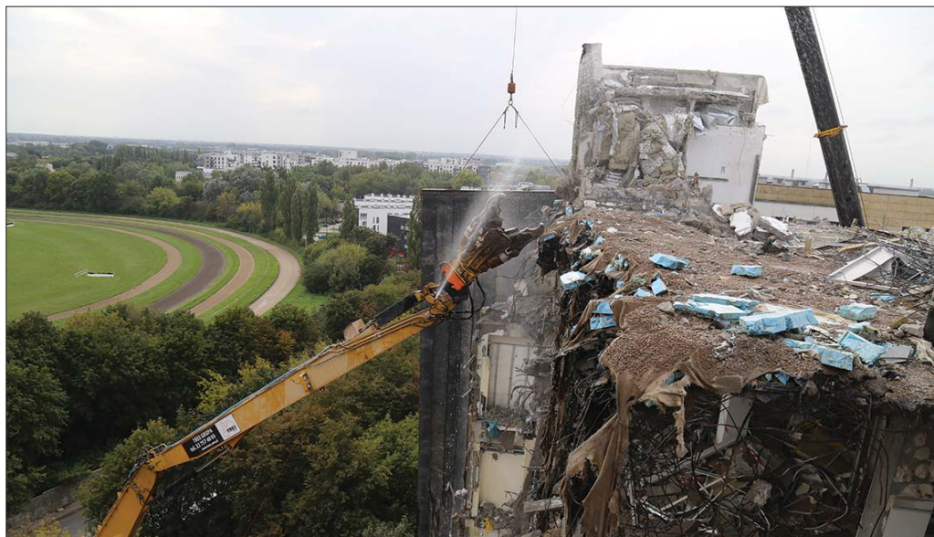
Profesjonalne firmy wyburzeniowe wykorzystują maszyny, które zostały fabrycznie przystosowane do wykonywania tego typu zadań. Pozwala to skrócić czas trwania robót i uczynić je bardziej efektywnymi
