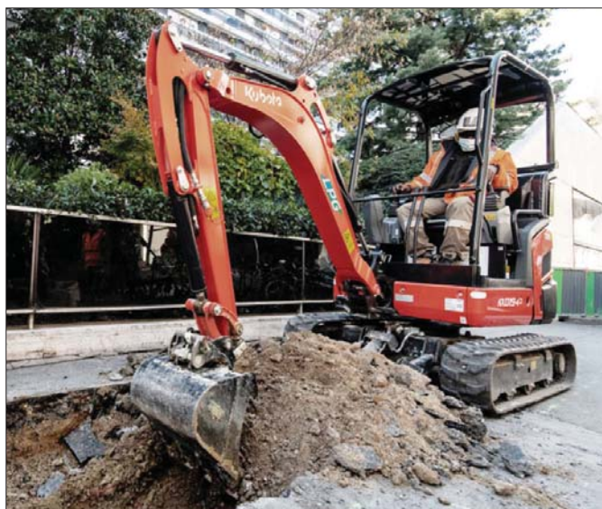
Wyposażona w silnik zasilany gazem koparka Kubota KX019-4 LPG emituje o 95 procent mniej zanieczyszczeń niż jej odpowiednik o konwencjonalnym napędzie
