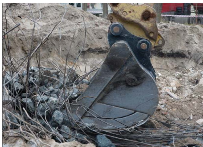
Wielu wykonawców wykorzystuje koparkowe łyzki podsiębiernie nie tylko do typowych prac ziemnych, ale także do wyburzeń
