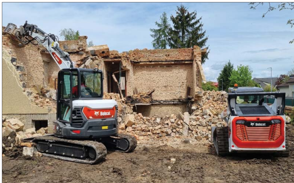
Trwające zaledwie dwa dni prace rozbiórkowe wykonywane były przy użyciu minikoparki Bobcat E55z, a załadunek gruzu następował kompaktową ładowarką gąsienicową Bobcat T76
