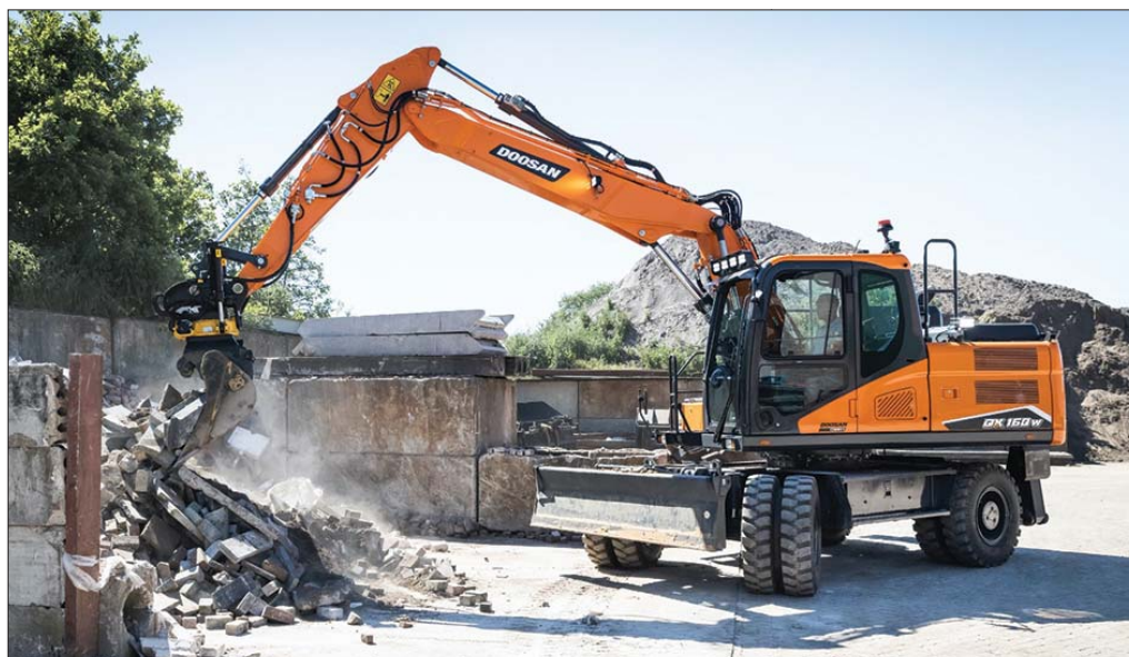
W najnowszej generacji koparek kołowych Doosan zastosowano cały szereg innowacyjnych funkcji, których zadaniem jest zwiększenie precyzji działania przy jednoczesnym ograniczeniu kosztów bieżącej eksploatacji
