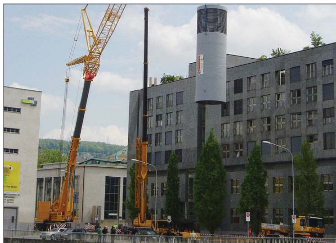
Operator dźwigu błyskawicznie posadził komin na dachu budynku zurychskiej giełdy
