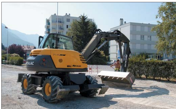
Konstrukcja koparek Mecalac sprawia, że sprawdzają się one doskonale w pracach inżynierskich prowadzonych w obszarach zurbanizowanych
