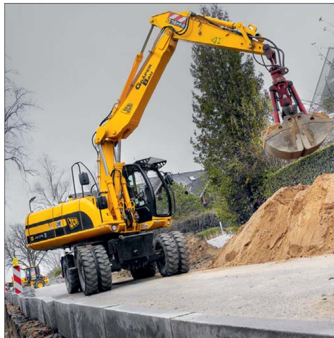
Koparki kołowe JCB potrafią poruszać się z dużą szybkością, mogą zatem podążać za frontem robót nie niszcząc przy tym nawierzchni...
