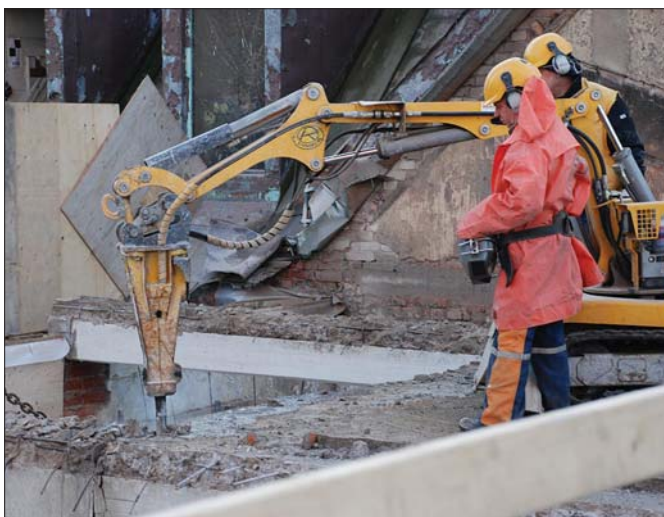
Podczas wyburzeń części zabytkowego młyna wykonawca użył robota Brokk 90 wyposażonego w młot hydrauliczny Atlas Copco SB 150
