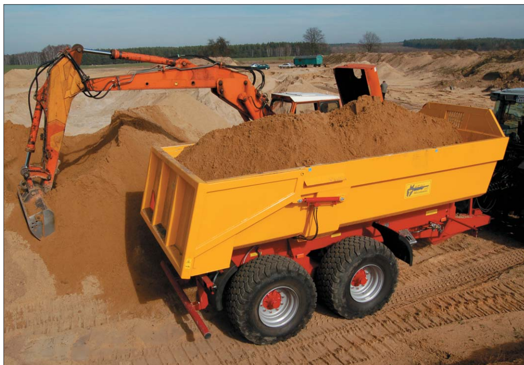
Zestaw ciągnik plus przyczepa to bardzo efektywny środek transportu na placu budowy
