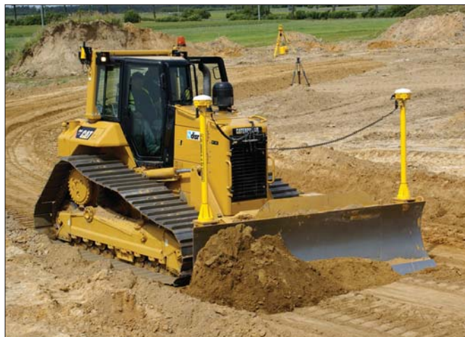
VirtualSite Solutions nie jest pierwszym wspólnym przedsięwzięciem Caterpillara i Trimble. Już w roku 2002 obie firmy sformalizowały współpracę dotyczącą rozwoju systemów sterowania pracą maszyn. Jej dobre efekty dały podstawę powołania do życia kolejnej spółki...
