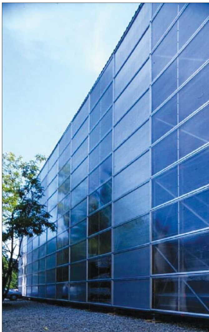
System łączników i elementów narożnikowych pozwala obudować praktycznie każdy obiekt, nawet z możliwością dobudowy do wysokości dziewięćdziesięciu metrów
