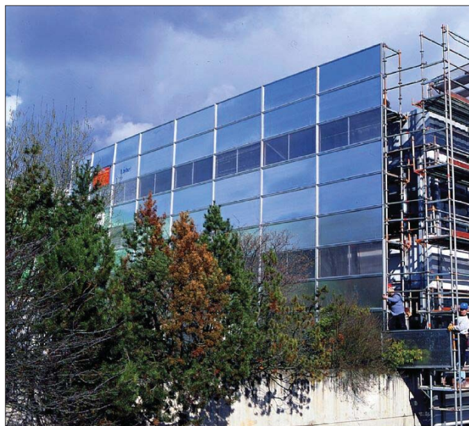
Konstrukcja systemu PROTECT wykonana jest z aluminium i stali ocynkowanej, zaś specjalne kasety ścienne z tworzyw sztucznych
