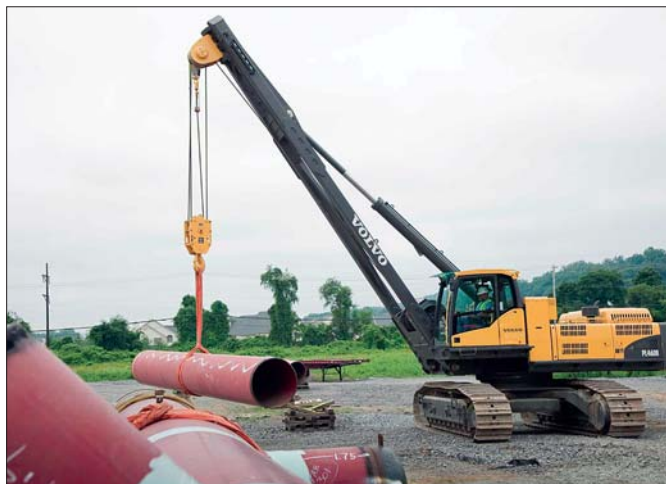
Powstała na bazie koparki hydraulicznej układarka PL4680 stanowi ciekawą alternatywę dla maszyn z osprzętem wysięgnikowym mocowanym z boku ramy
