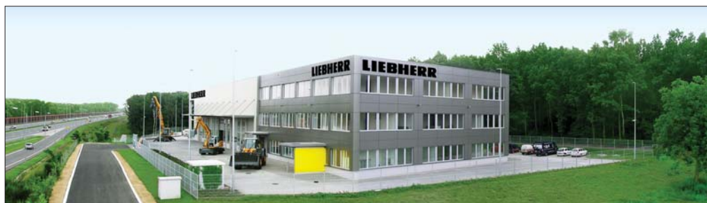
Nowa siedziba Liebherr Polska w Rudzie Śląskiej
