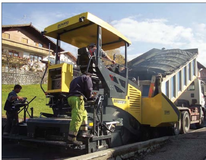
Układarkę Bomag BF 300 cechuje wysoka wydajność pracy
