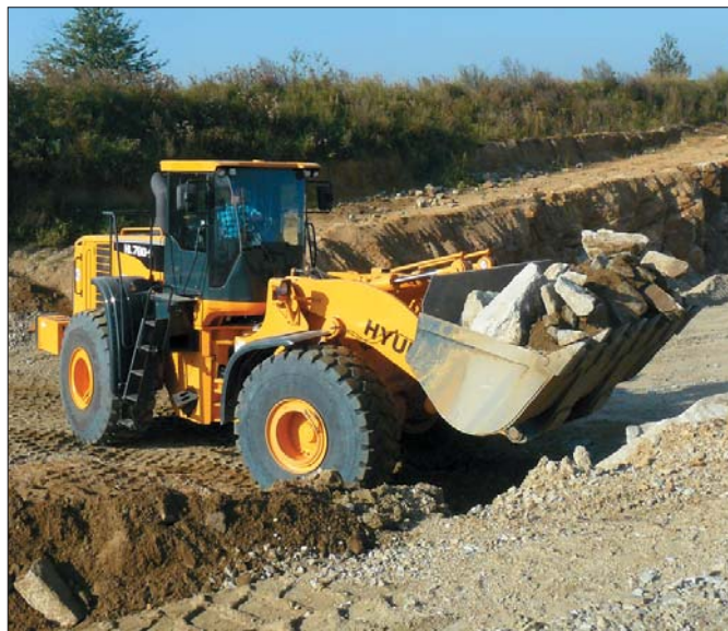
Na przełomie września i października ładowarka Hyundai HL780-9 pracowała w kopalniach odkrywkowych, żwirowniach i piaskowniach zbierając zewsząd pochlebne recenzje
