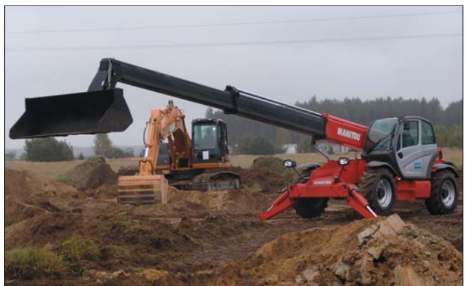
Manitou MRT2150 Turbo potwierdziła wysokie możliwości manewrowe, co jest szczególnie ważne na placach budowy o ograniczonej przestrzeni
