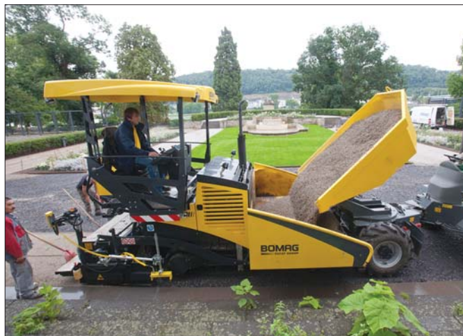
Bomag BF 300 uporał się z położeniem nawierzchni parkowych alei w ciągu dwóch dni
