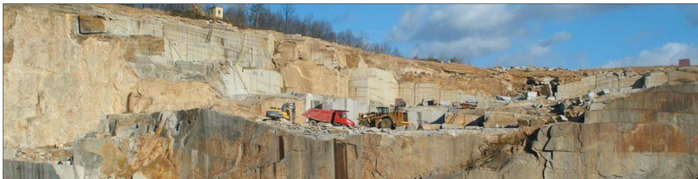
Złóża granitu eksploatowane są od ponad stu lat. W powstałym przez ten czas wyrobisku nawet tak potężne maszyny, jak Cat 988H wyglądają jak zabawki
