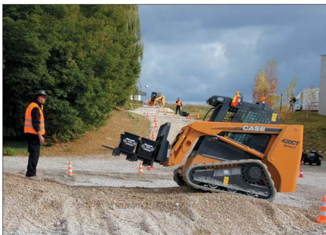
Słalom skid steerem wymagał pokonania trasy przodem, a następnie tyłem. Kłopoty z wodnikiem sprawiło transportowanie na widłach kontenerów wypełnionych wodą
