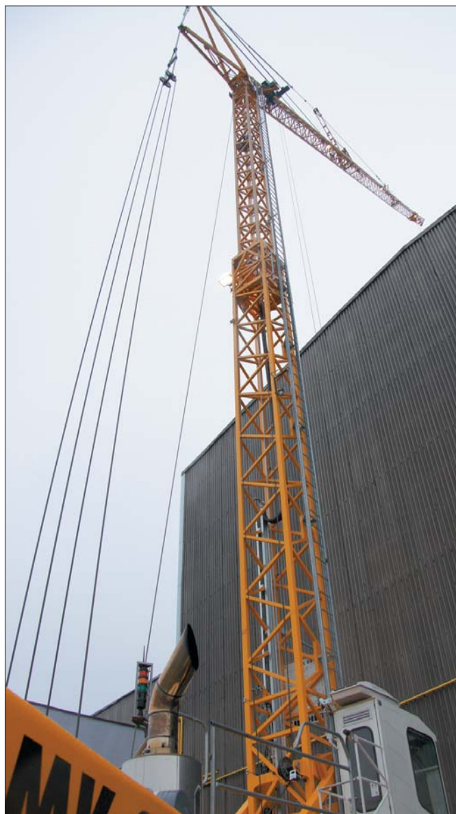
Pionowa wieża daje możliwość montażu i eksploatacji żurawia MK 88 bezpośrednio przy budynku. Dzięki temu w sposób optymalny wykorzystuje się całkowitą długość wysięgnika
