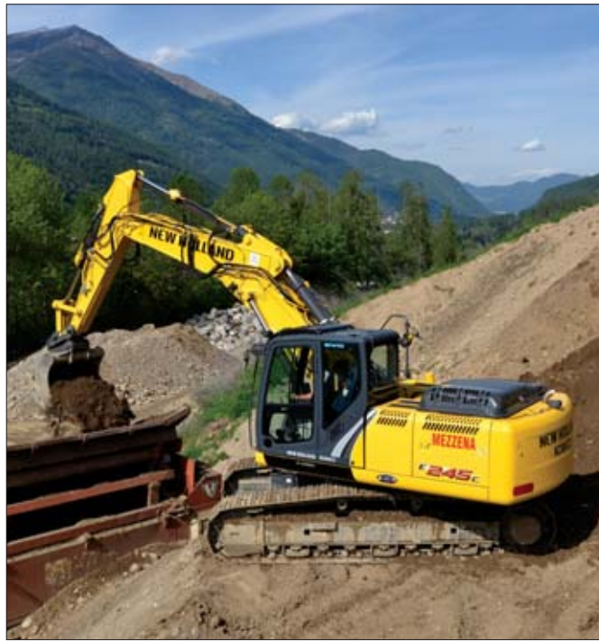
Piękna sceneria, ciężkie warunki robocze. Tak wygląda codzienne środowisko pracy koparki gąsienicowej New Holland E245C
