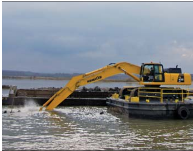
Praca na pontonie jest w pełni bezpieczna. Operatorzy koparki nie muszą posiadać żadnych uprawnień do pracy na wodzie
