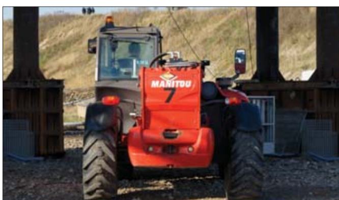
Dla firmy RAMB liczy się kompaktowa budowa maszyn Manitou. Dzięki zwartym gabarytom ładowarki poruszają się z łatwością w gąszczu stalowych konstrukcji
