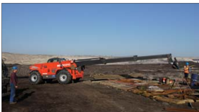
Manitou prezentuje pełen wysięg. Podczas pracy z widłami ładowarka służyć może do prac przeładunkowych, porządkowych oraz transportu na bliskie odległości
