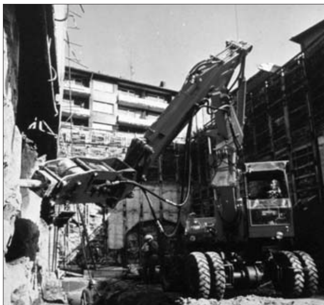
HM 400 – pierwszy na świecie hydrauliczny młot udarowy montowany na wysięgniku koparki opatentowano w roku 1963
