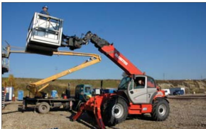
Dzięki dużemu wysięgowi i stabilności ładowarka Manitou MT 1840A pracując z koszem roboczym sprawdza się doskonale przy pracach montażowych
