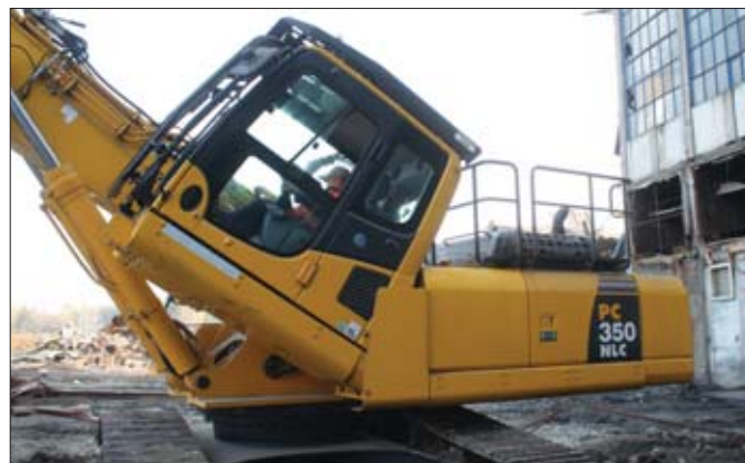
Kabina odchylana do góry o kąt 30° ułatwia prowadzenie prac rozbiórkowych przy maksymalnym wysięgu osprzętu roboczego
