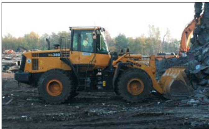
Ładowarka kołowa Komatsu wykorzystywana jest między innymi do prowadzenia prac porządkowych terenu, na którym prowadzone były roboty wyburzeniowe
