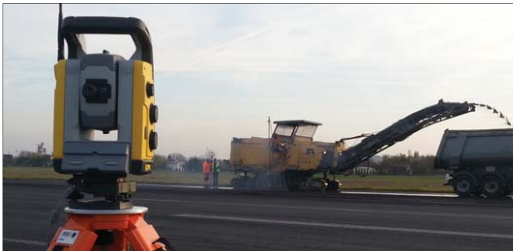
Frezowanie nawierzchni asfaltowej pasów startowych w Porcie Lotniczym Gdańsk im. Lecha Wałęsy przeprowadzono z wykorzystaniem Trimble PCS900 Paving Control System 3D UTS. Wykonawcą robót była firma SAT Sp. z o.o.
