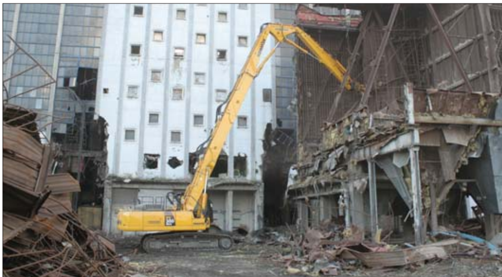
Koparka Komatsu PC 350NHRD-8 o masie własnej wynoszącej blisko 48 ton i wysięgu przekraczającym 23 metry to najnowszy nabytek firmy Stal-Met. Maszyna spisywała się doskonale podczas prac rozbiórkowych na terenie Elektrowni Halemba
