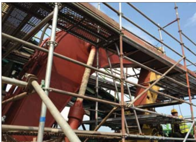
Odbudowa maszyny na statku wymagała montażu specjalnego rusztowania, które gwarantowało odpowiedni dostęp i bezpieczeństwo prowadzonych prac
