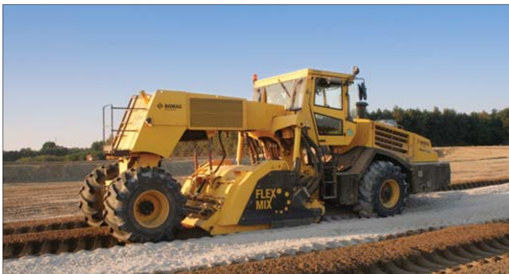
Stabilizowanie gruntu w pasach drogowych zwykle odbywa się do głębokości 200-300 mm. W wytwórni podbudów Onyx Enterprise bęben jest opuszczany na głębokość 500-600 mm, w pełni wykorzystując możliwości MPH 600 4i
