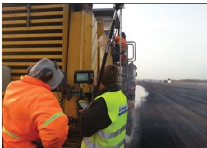
SPS930 bardzo precyzyjnie prowadzi bęben frezarki, umożliwiając frezowanie na podstawie trójwymiarowego modelu terenu z dokładnością do 2-3 milimetrów
