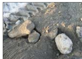
W stabilizowanym gruncie zdarzają się kłopotliwe wtrącenia w postaci kamieni czy gruzu, powodujące przyspieszone zużycie lub nawet uszkodzenia frezów
