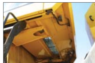
W podłodze kabiny znajduje się niewielkie przeszklenie pozwalające na obserwację przewodów hydraulicznych z wysokim ciśnieniem
