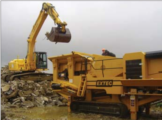
Zastosowanie kruszarki Extec pozwala na zagospodarowanie na miejscu gruzu i materiału stanowiącego pozostałości po pracach wyburzeniowych
