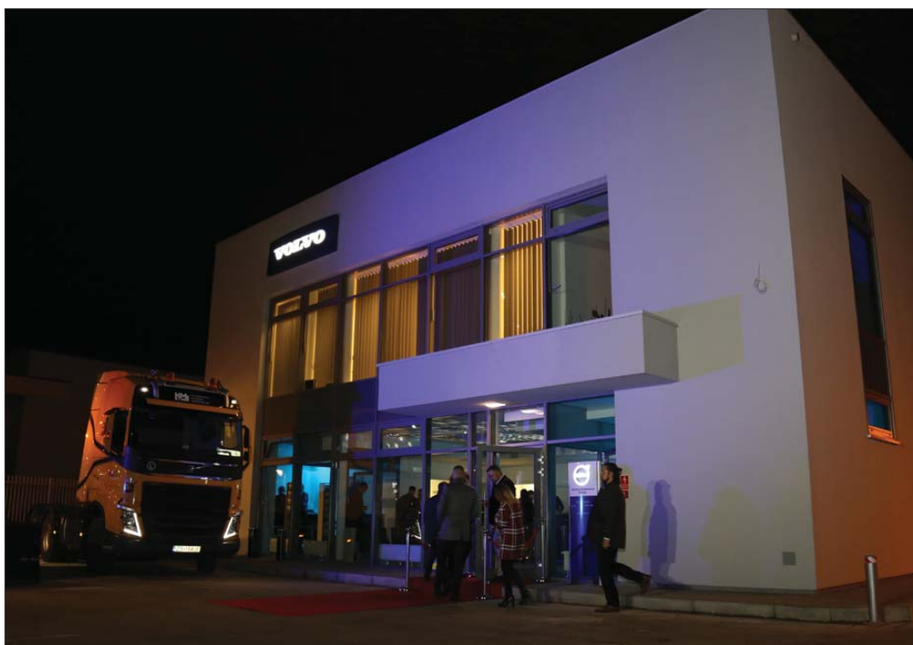
Tak prezentuje się budynek nowego oddziału serwisowego Volvo Maszyny Budowlane Szczecin, w którym firma jest wreszcie u siebie. Poprzedni obiekt, mieszczący się zresztą przy tej samej ulicy, dzielić musiała z dwoma innymi najemcami
