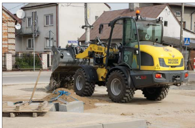
Zakupiona przez PDM Pisz ładowarka wykorzystywana jest także w tradycyjny sposób do przemieszczania materiałów budowlanych.
