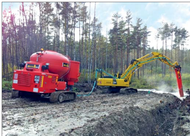
Zadaniem podajnika ciśnieniowego montowanego na podwoziu gąsienicowym jest wprowadzanie węzami w podłoże spoiwa za pomocą sprężonego powietrza
