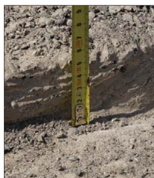
Frezarką dokonywać można precyzyjnego cięcia nawet na nierównej powierzchni
