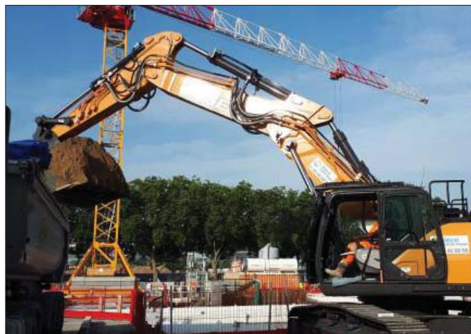
Wykonawca robót zdecydował się na wysięgnik w konfiguracji umożliwiającej kopanie na większą głębokość i wybieranie mas ziemnych z samego dna wykopu
