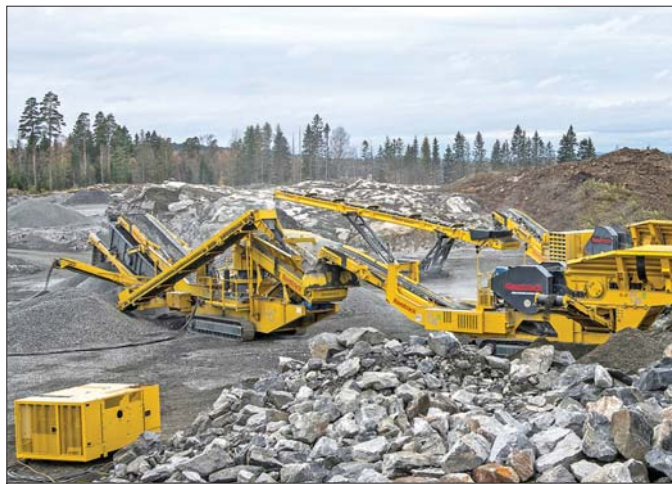
Użytkownik maszyny elektrycznej nie ma tych problemów w przypadku awarii silnika Diesla. Aby nie przerywać pracy, musi tylko przejść na zewnętrzne źródło zasilania
