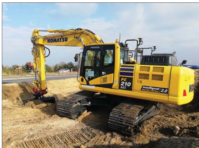
Koparka Inteligentna Komatsu iMC 2.0 podczas pracy na budowie autostrady A1 w okolicach Piotrkowa Trybunalskiego
