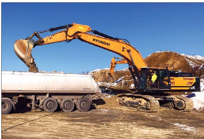
Najnowszy nabytek Murpolu to pięćdziesięciotonowa koparka Hyundai HX 520L, która znajduje szerokie zastosowanie w kopalni piaskowca Szufnarowa
