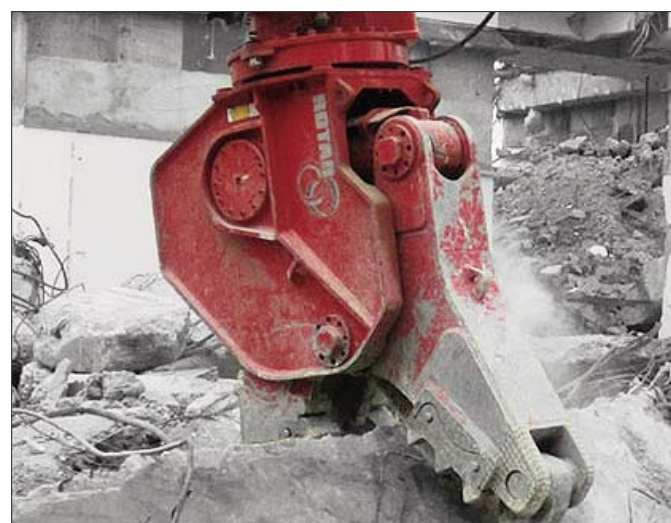
Nożyce bez najmniejszego problemu radzą też sobie z precyzyjnym cięciem metalowych elementów konstrukcji budynków
