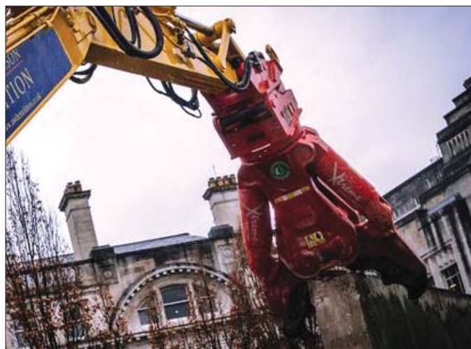
Osprzęt wyburzeniowy Rotar sprawdził się idealnie podczas prac związanych z rewitalizacją terenów Piccadilly Gardens w Manchesterze
