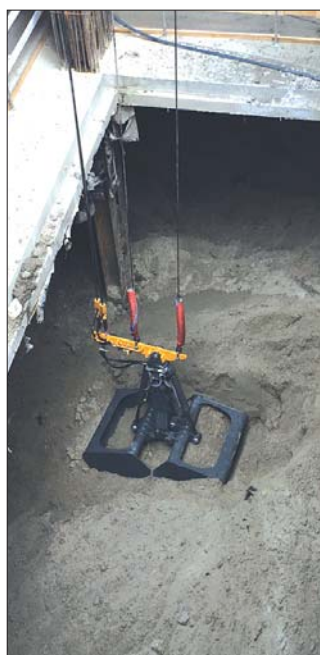
Operator może sięgnąć osprzętem aż do sześciu kondygnacji w dół wykopu
