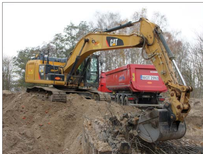
Szybsze ukończenie prac rozbiórkowych wystuzonego budynku kina w Helu umożliwiły między innymi wytrzymałe łyżki Dekpol Steel
