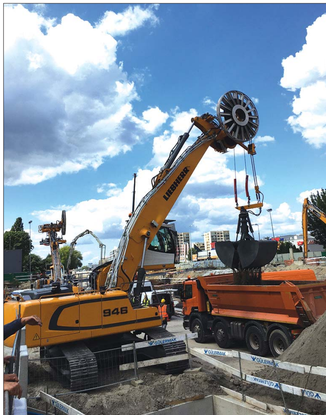
Dzięki zamontowanej na ramieniu wysięgnika wciągarka koparka może wydobywać urobek i odkładać go na poziomie gruntu albo ładować bezpośrednio na ciężarówkę
