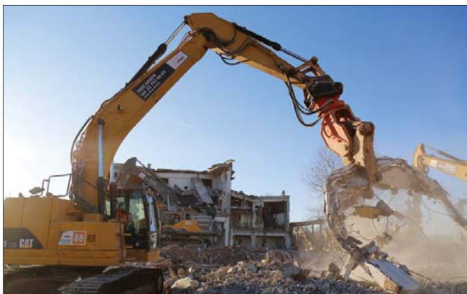
Stosowanie wysokiej klasy sprzętu wyburzeniowego stanowi gwarancję efektywności i bezpieczeństwa prowadzonych prac
