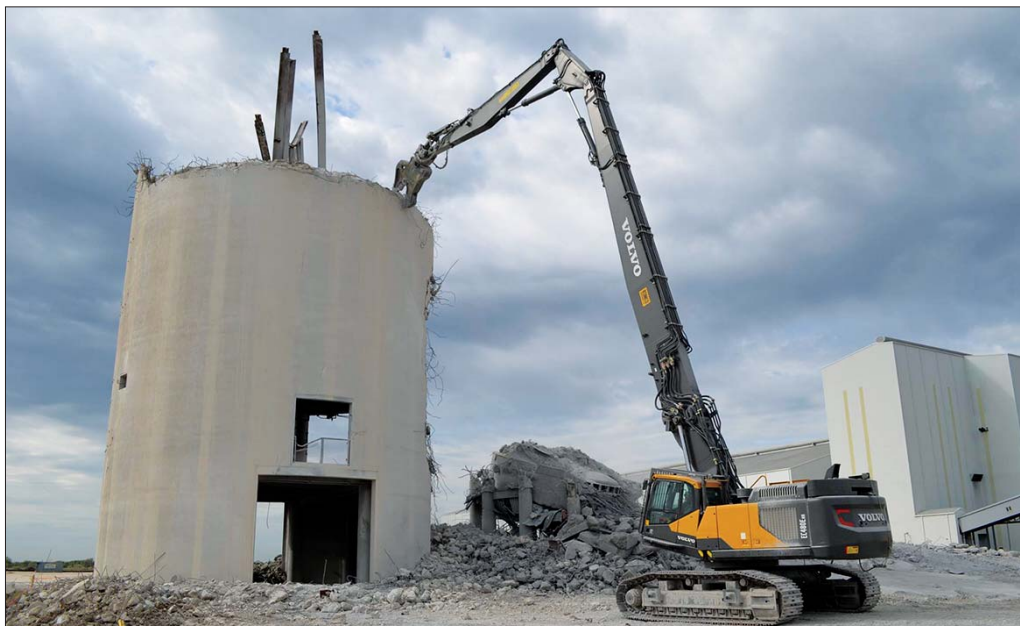
Wytrzymała rama i wzmocniona kabina skutecznie chronią koparkę przed spadającymi elementami konstrukcji i gruzem będącymi typowymi zagrożeniami występującymi podczas prac wyburzeniowych
