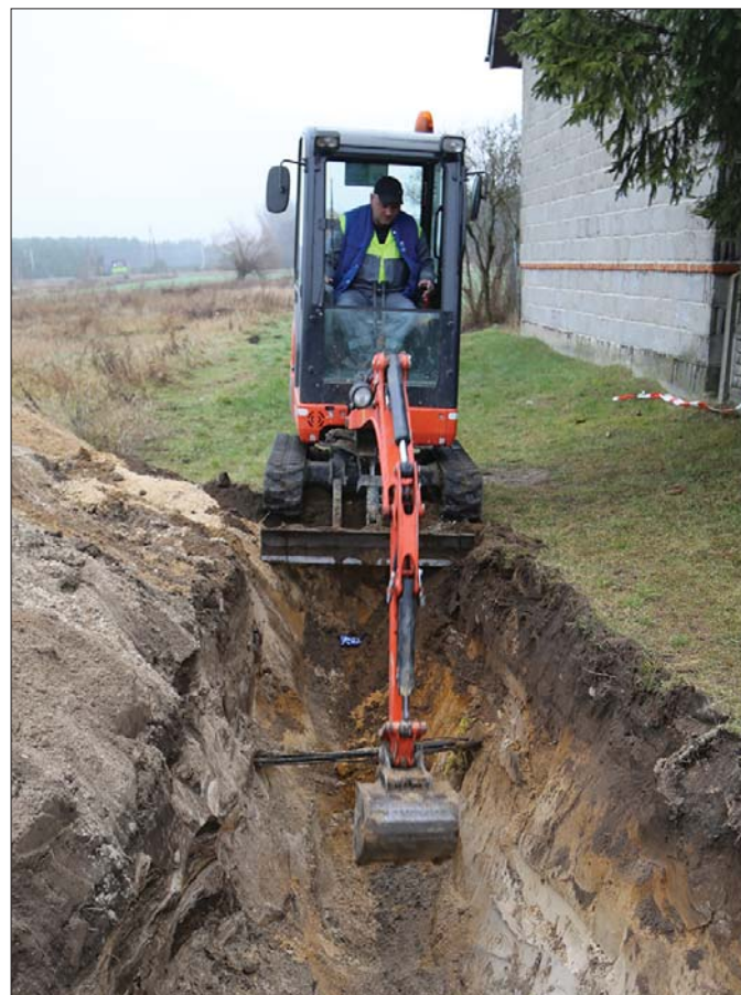
Mala maszyna, a wykop szeroki i głęboki. Zestawienie tych dwóch faktów dobrze świadczy o możliwościach minikoparki Kubota KX018-4
