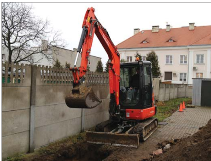
Zwrotność i kompaktowa budowa niemal 4-tonowej koparki Kubota sprawia, że bez problemu może być używana w ciasnych przestrzeniach miejskiej infrastruktury.
