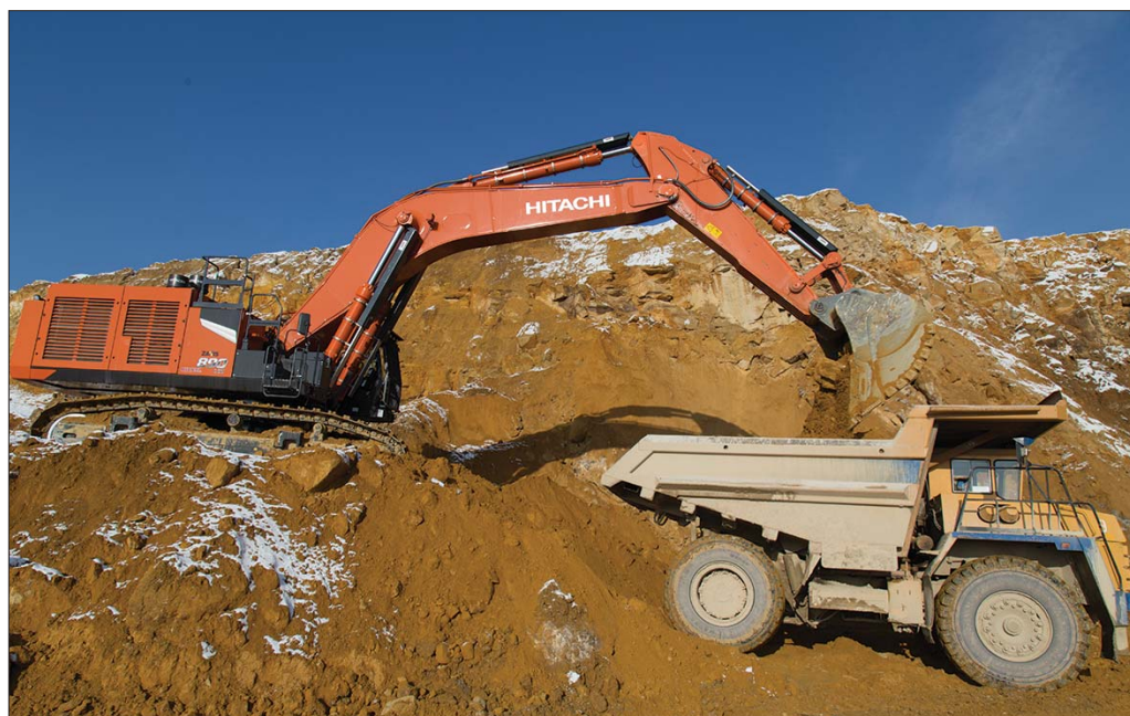
Operator gigantycznej koparki nie ogranicza swych działań do przygotowania sobie stanowiska pracy. Zdejmuje także kolejne warstwy nadkładu oraz załadunku odstrzelony urobek na kursujące nieustannie wozidła
