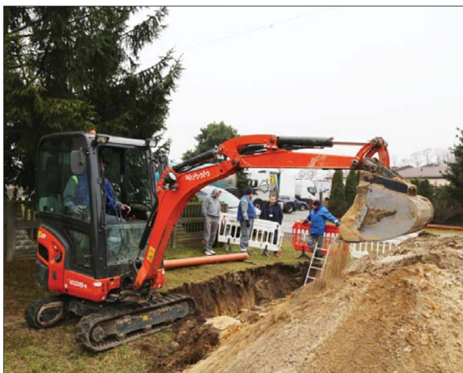
Dzięki stosunkowo niskiej masie własnej oraz zastosowaniu gumowych gąsienic – maszyna może przemieszczać się po wymagających nawierzchniach – nie powodując ich zniszczenia.
