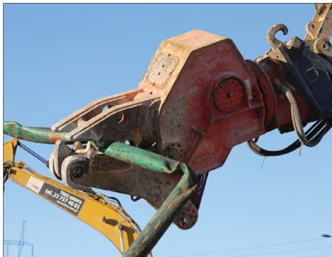
Na początku Grupa Tree wypróbowała narzędzia podczas robót wyburzeniowych budynków dawnej fabryki Polfa w Warszawie
