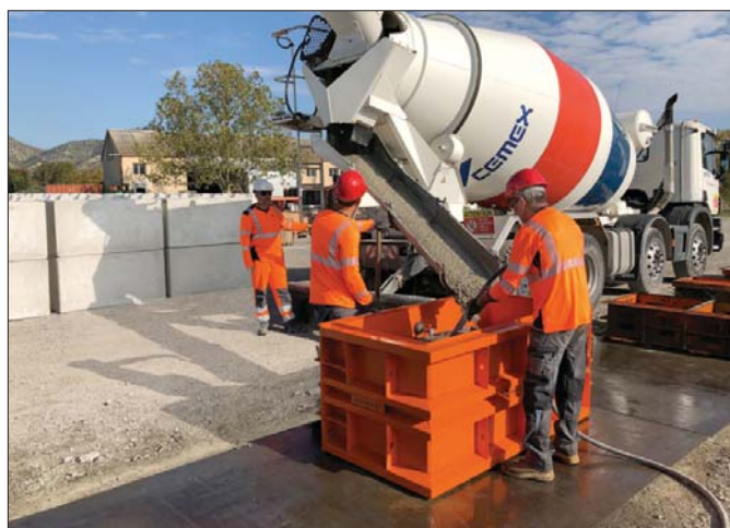
△ Napełnianie form nie wymaga żadnych specjalnych umiejętności. Cały proces powstawania betonowych elementów ogranicza się praktycznie do funkcji kontrolnych
