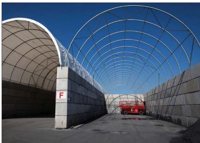
△ Komory zbudowane z bloczków BETONBLOCK w razie potrzeby można bez większego trudu przykryć konstrukcją dachową
