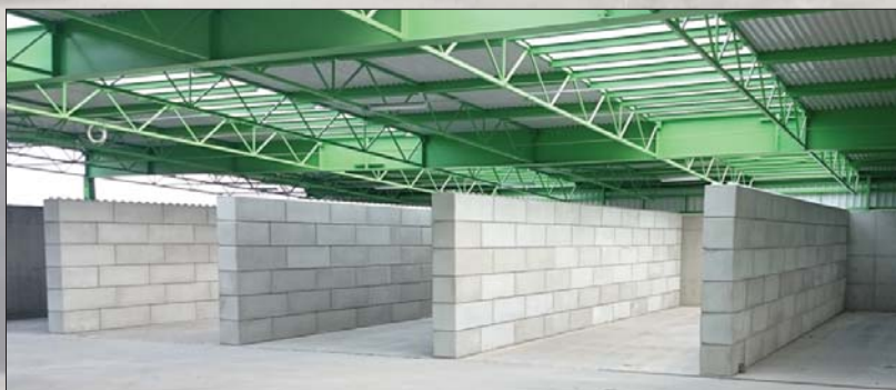
▽ Do budowy pomieszczeń z prefabrykatów BetBlok System nie jest wymagane pozwolenie budowlane. Bloki nie są trwale połączone z gruntem, a jedynie luźno ułożone na przygotowanej wcześniej posadzce
