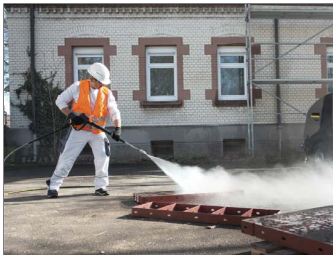
△ Myjki doskonale nadają się do czyszczenia powierzchni o skomplikowanych kształtach i trudno dostępnych elementach
