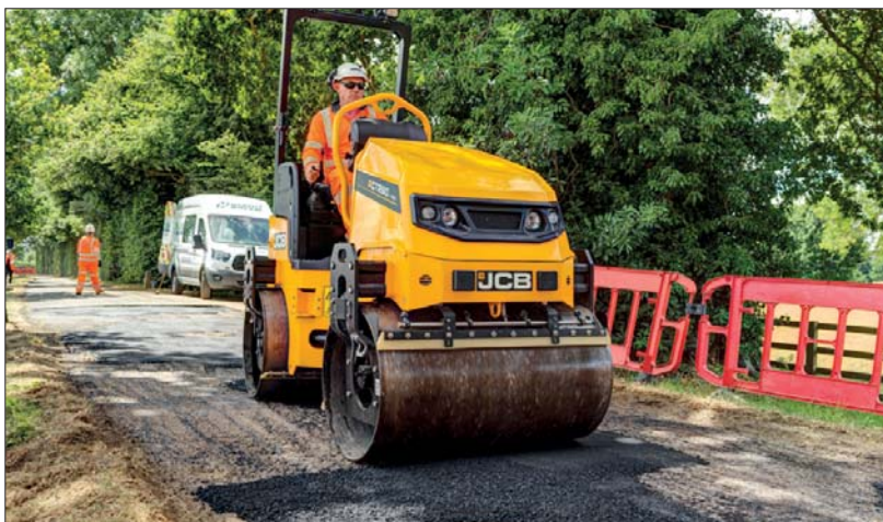
△ Budowa ścieżek rowerowych, dróg dojazdowych oraz alejek parkowych to tylko niektóre przykłady zastosowań tandemowych walców JCB
