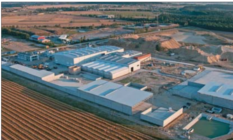
△ Zakład Gospodarki Odpadami w Jarocinie, stan prac na sierpień 2015 roku
