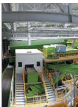
△ Projekt rozbudowy ZGO Jarocin obejmuje m.in. linię sortowniczą z czterema separatorami fotooptycznymi, komorę fermentacyjną z zespołem kogeneracyjnym, kompostownię oraz kwaterę składowiska
