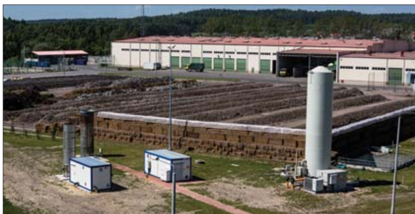
▽ Widoczny na zdjęciu plac dojrzwiania kompostu był sprawcą uciążliwego odoru. Na 2 hektarach przetwarzano tu jednocześnie nawet 7.000 ton odpadów organicznych. Na szczęście obecnie został oczyszczony, a w tym miejscu powstanie hermetyczna kompostownia
