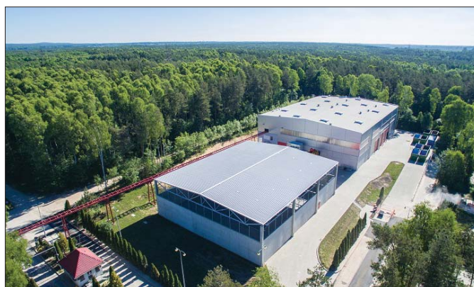
△ Zakład FB Serwis w Kamięnsku dysponuje jednymi z najnowocześniejszych w Polsce instalacjami do odzysku cennych surowców z odpadów komunalnych
