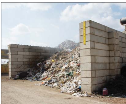
△ BetBlok System umożliwia ▽ budowę ścian praktycznie w dowolnym miejscu, a w ra- zie potrzeby można je szyb- ko zdemontować i przenieść do nowej lokalizacji
