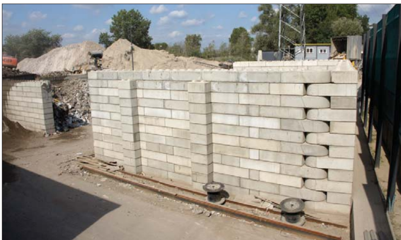
△ BetBlok System umożliwia ▽ budowę ścian praktycznie w dowolnym miejscu, a w ra- zie potrzeby można je szyb- ko zdemontować i przenieść do nowej lokalizacji
