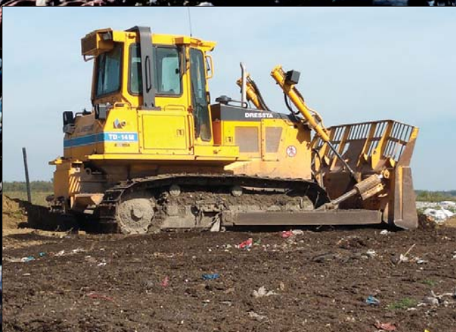
▲ Przez ponad cztery lata odpady zagęszczała spycharka Dressta 14M. To między innymi zastępują jej skutecznej pracy był zakup kolejnej maszyny tej marki
