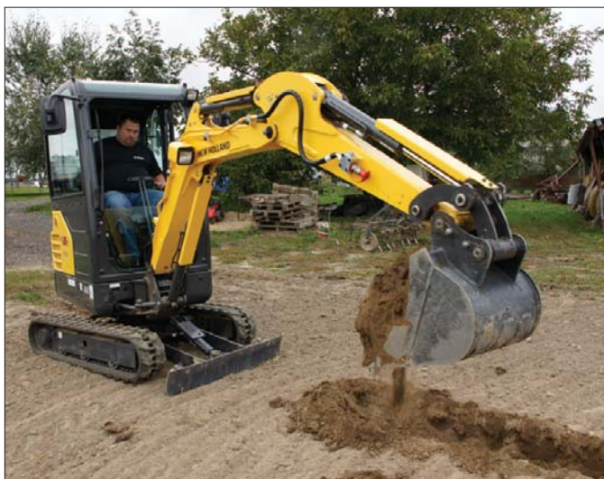
△ Karol Wiśniewski zdążył sprawdzić, jak maszyna radzi z wykopami pod fundamenty i instalacje wodociągowe
