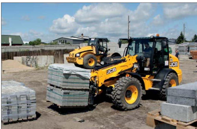
△ Firma JANSZ swoją działalność rozpoczęła od prac brukarskich. Obecnie nadal je wykonuje, a pomaga im w tym między innymi ładowarka teleskopowa JCB
