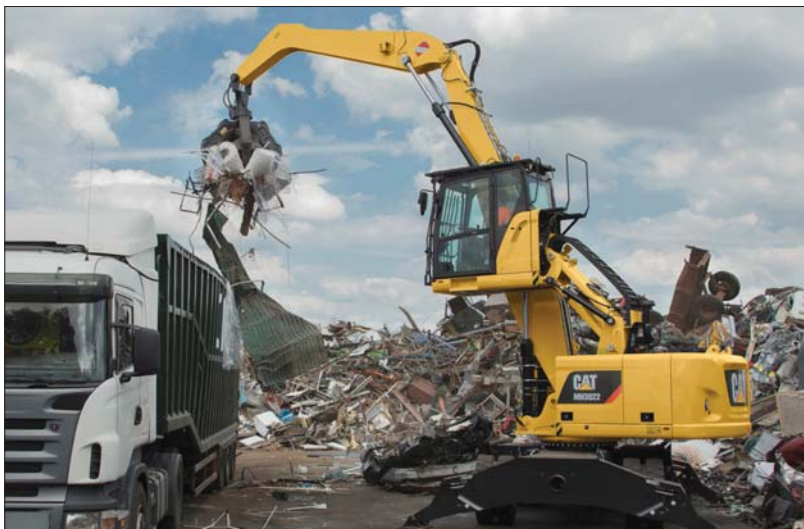
△ Koparka kołowa Cat MH3022 doskonale sprawdza się na wszystkich placach przeładunkowych. Duża stabilność maszyny umożliwia jej przemieszczanie materiałów nawet na odległość jedenastu metrów
