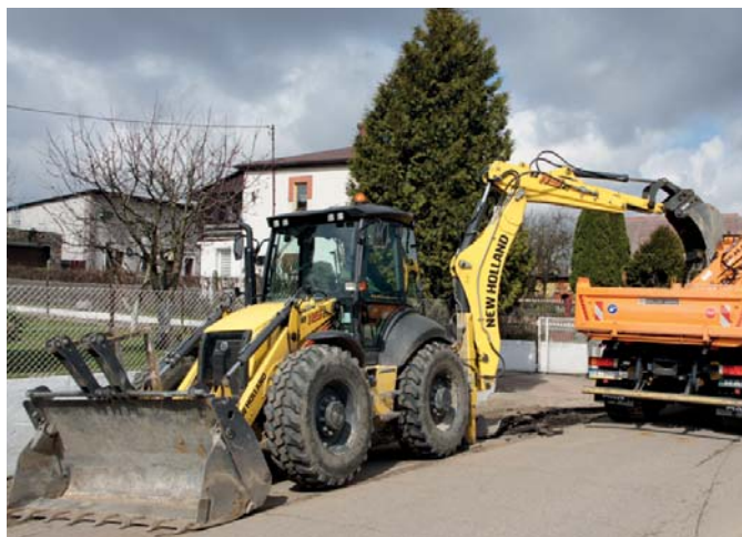
△ Aktualnie koparko-ładowarka B 115C pracuje w miejscowości Radoszki, gdzie wykorzystywana jest przy wymianie nawierzchni oraz budowie kanalizacji burzowej
