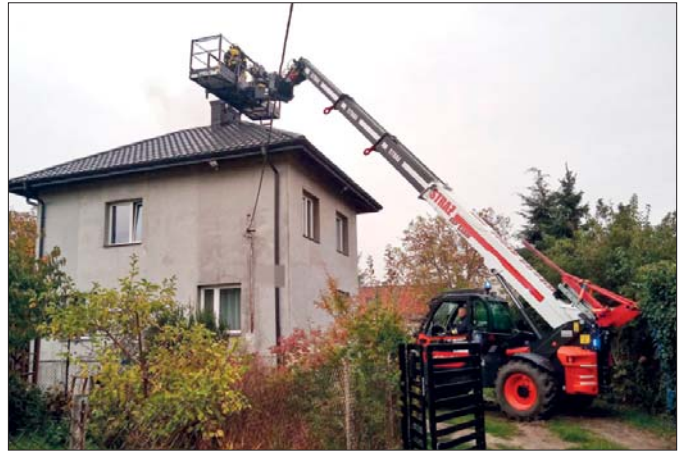
△ Ładowarka teleskopowa Bobcat bierze udział w wielu akcjach strażaków, w tym także nietypowych i skomplikowanych zastosowaniach
