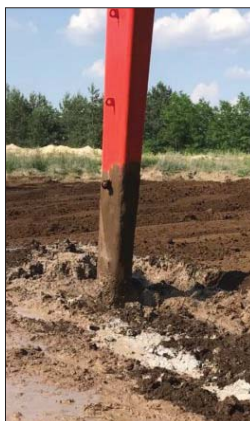
△ Prace w Stalowej Woli polegały na odseparowaniu odpadów i usunięciu ich ze zbiorników, tak aby przestały zagrażać wodom gruntowym
