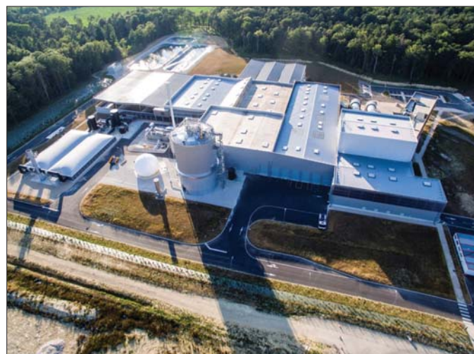
△ Zakład w Bourgen-Bresse może przekształcać rocznie 66.000 ton odpadów zmieszanych oraz 7.500 ton odpadów zielonych w kompost i energię elektryczną
