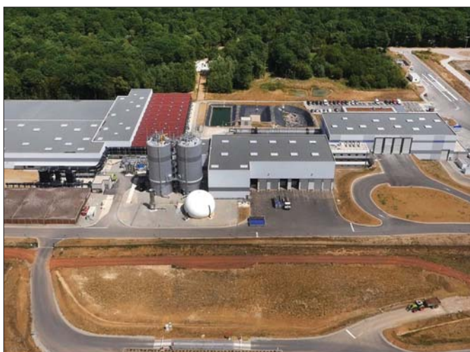
△ Przykładem wykorzystania systemu DRANCO jest zakład w Chagny, który odpowiada zarówno za sortowanie odpadów, jak i za ich metanizację oraz kompostowanie
